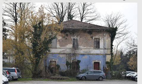
3 Vista della Stazione dal piazzale adibito a parcheggio
