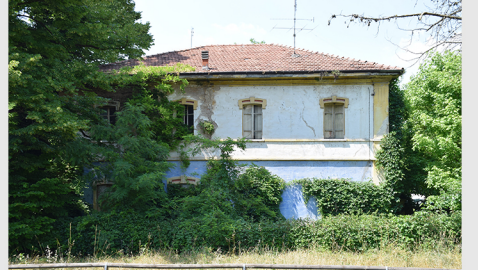
2 Vista della Stazione da sud, da Via Andrea Mantegna
