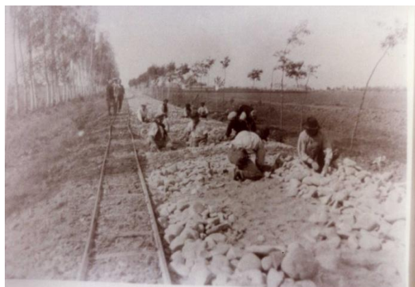
Fig. 2 Lavori di costruzione del tracciato ferroviario
