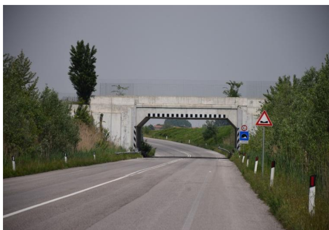
Fig. 9 _Il ponte sulla tangenziale di Porto Mantovano
