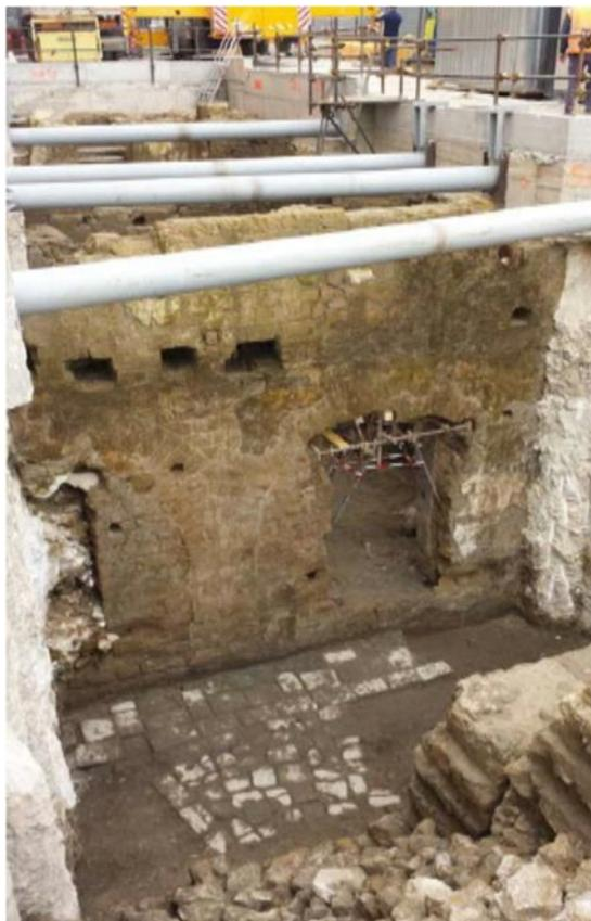
*Figura 52 Sistemazione delle strutture statiche che impediscono l'implosione dello scavo.*
