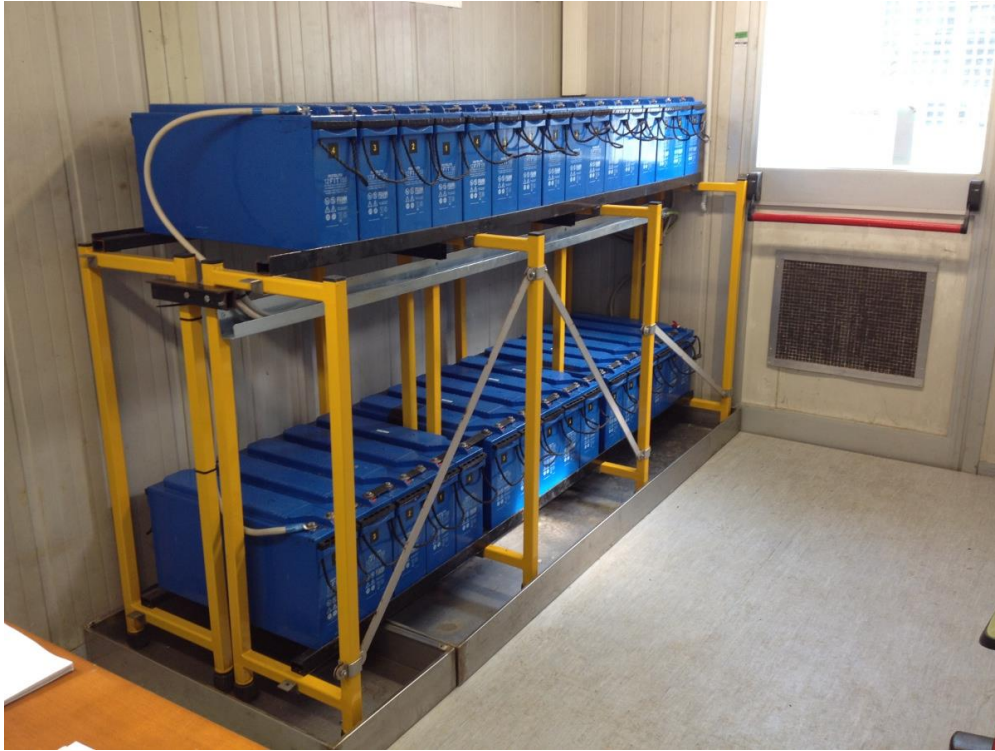
Figura 13 Batteria al piombo composta da 31 moduli in serie
