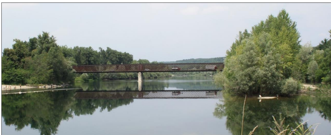
Figura 2-47: Ponte SS494 Oleggio (NO)
