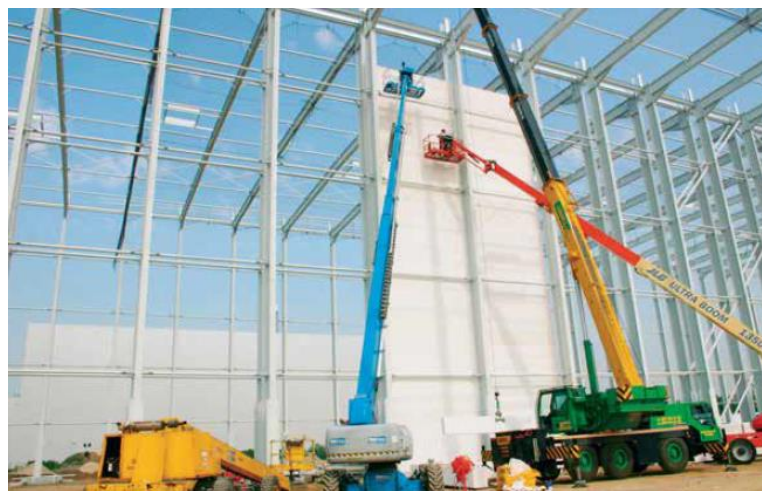
7.3 Esempio di montaggio di pannelli in calcestruzzo cellulare su struttura in acciaio
