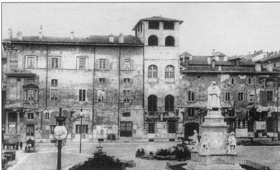
32. Immagine del 1880 della Piazza con l'antica facciata di Palazzo Marino
