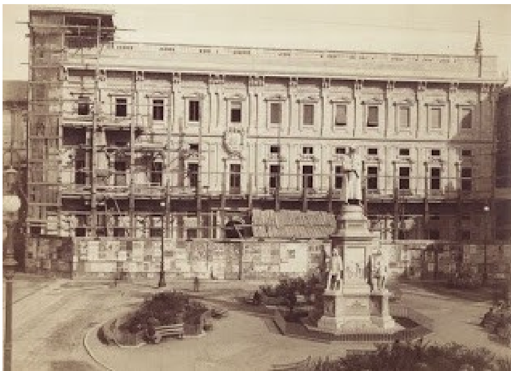
33. Immagine del 1892 della Piazza con la fine dei lavori di restauro della facciata di palazzo Marino
