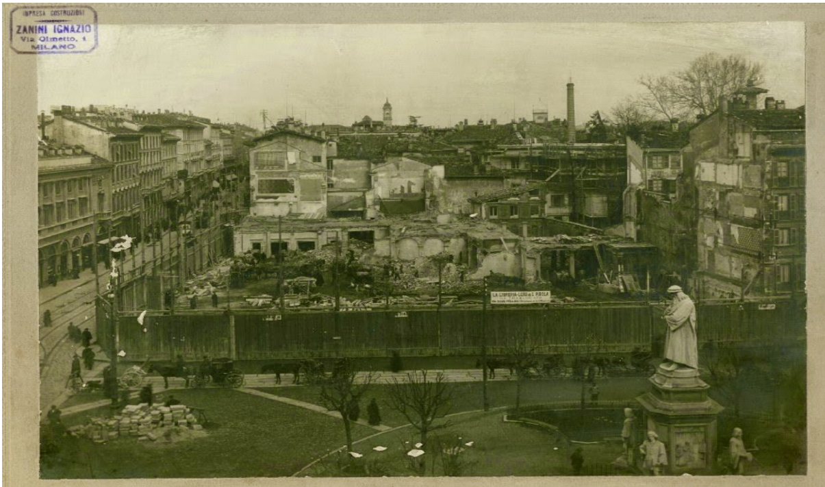
34. Demolizione degli edifici a est della Piazza su via Case Rotte
