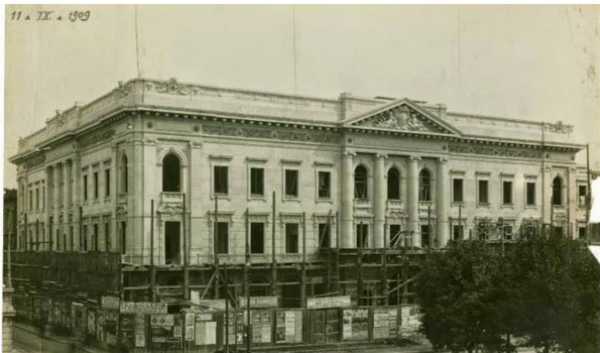
35. Edificio della Banca Commerciale Italiana su via Case Rotte ultimato nel 1911
