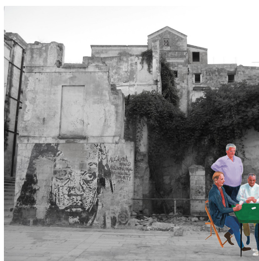
1. Crollo tra Postierla La Nuova e Via di Mezzo
