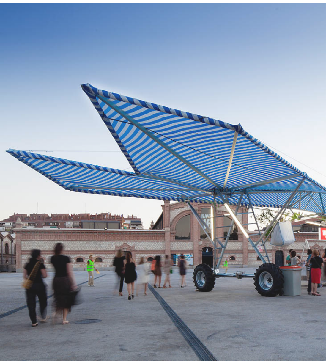
Fig. 2.32 La copertura mobile nella grande piazza interna è essenziale per dare riparo ai visitatori durante le calde estati madrilene
