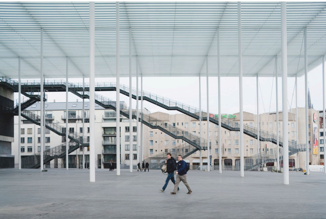
Fig. 2.25 Vista della piazza coperta, dove il senso di continuità visiva è dato sia dalla copertura piana, sia dalla pavimentazione uniforme priva di qualsiasi barriera <<
