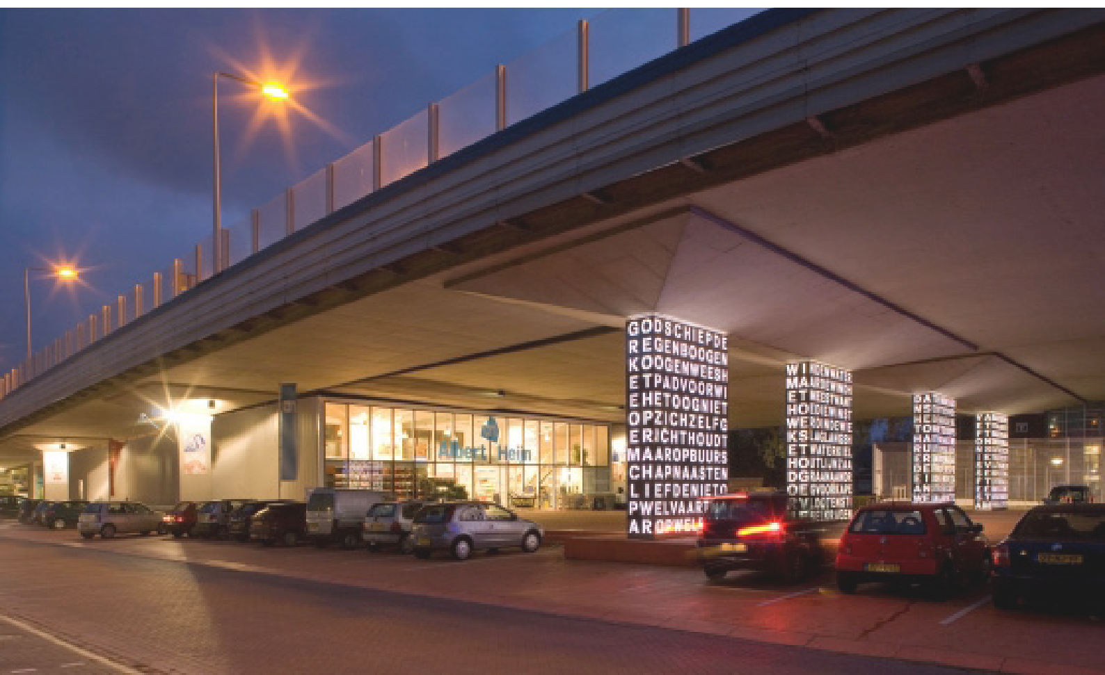
Fig. 2.51 Alcuni pilastri sono stati valorizzati da interventi di illuminotecnica <<
