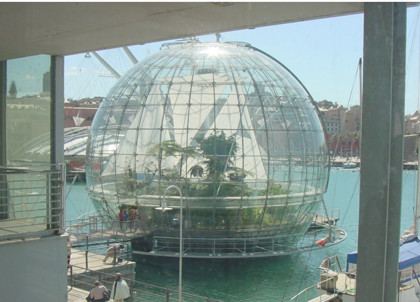
Fig. 2.18 In primo piano la Biosfera, una struttura in vetro e acciaio di 60 tonnellate, dal diametro di 20 metri, con all'interno un giardino botanico
