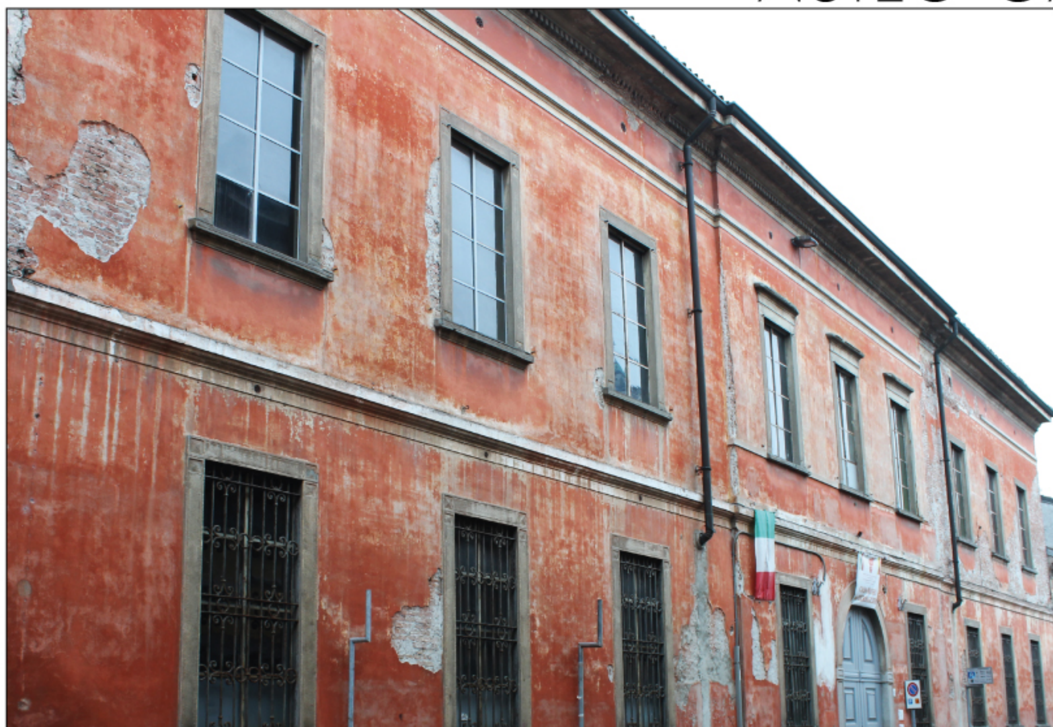
▲ Facciata dell'ex asilo Garibaldi su via Vistarini
