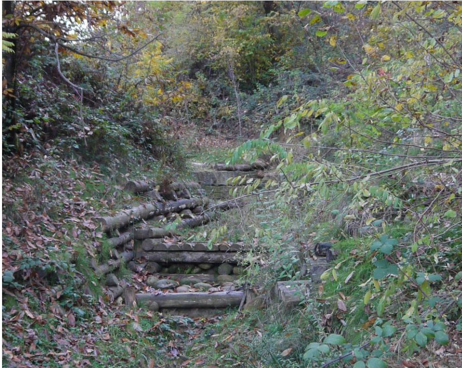
Figura 25 - Piccole briglie e protezioni spondali in legno lungo la Roggia Malmonte (Barozzi et al., 2015)
