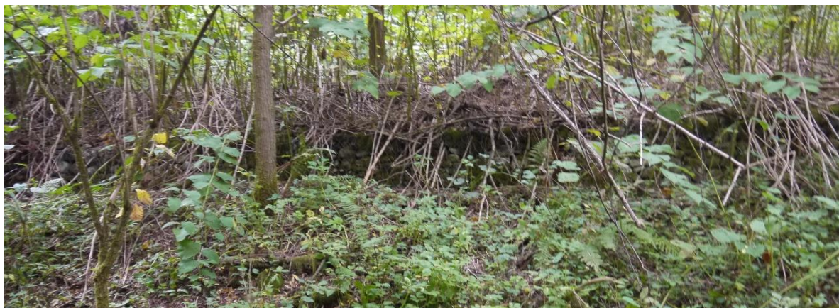
Figura 26 - Gabbionata metallica presente in prossimità della roggia Vallone (Barozzi et al., 2015)
