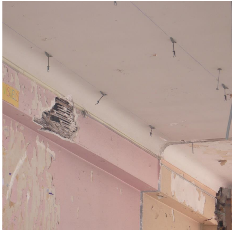
Figure 216 : Groupe scolaire Eugène Varlin, Pierrefitte-sur-Seine (93), La Guilde des Architectes et Techniciens conseils, 1935. Photographie personnelle. Date de prise de vue : 24 mai 2016.
