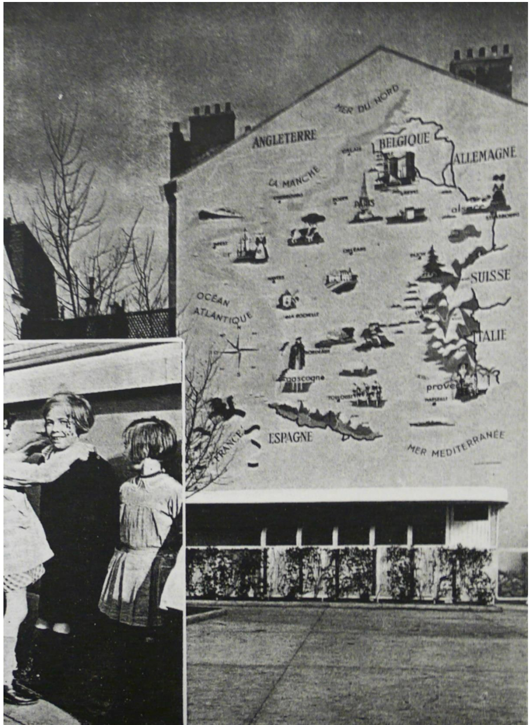
Figure 205 : Groupe scolaire Marius Jacotot, Putaux (92), Jean et Édouard Niermans architectes, 1938. In BARTHÉLÉMY, Georges. Groupe scolaire Marius Jacotot. Puteaux (Seine) . Paris : Éditions des Documents modernes, s.d., s.p. Le pignon voisin de la cour de récréation est revêtu d'une grande fresque illustrant la France, ses paysages et ses traditions régionales, indiquant également les pays voisins, les mers et l'océan.
