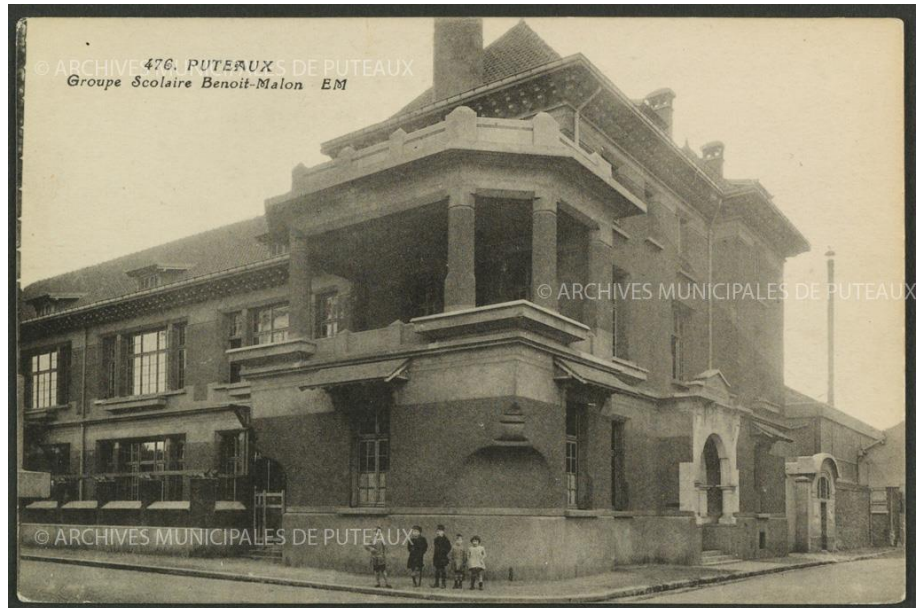
Figure 110 : Groupe scolaire Benoit Malon, école maternelle. Paul-André Roy et Paul Lorenz, architectes, 1926. AM de Puteaux. Disponible en ligne : http://www.puteaux.fr/fileadmin/archives/carte_postale/2Fi0423.jpg , consulté le 25 février 2014.
