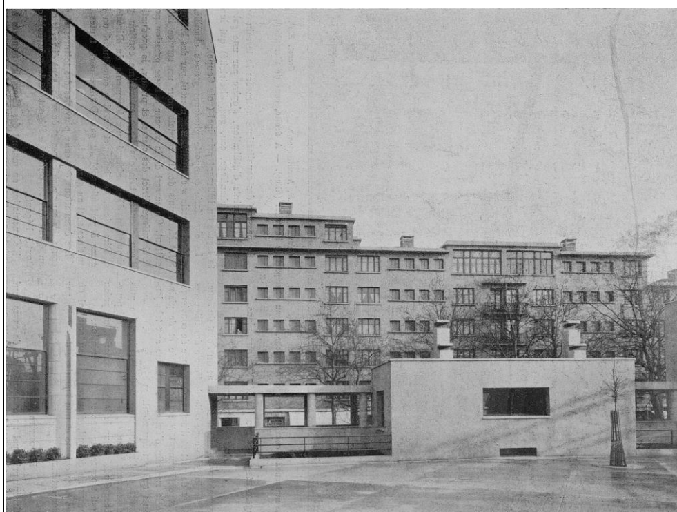
Figure 79 : Écoles de Billancourt (Seine) -. MM. Cauwet et Ogé, Architectes. Cour de l'école de garçons, côté pavillon du concierge. In La Construction moderne , 16 avril 1933, 48 ème année, n°29, p. 439.
