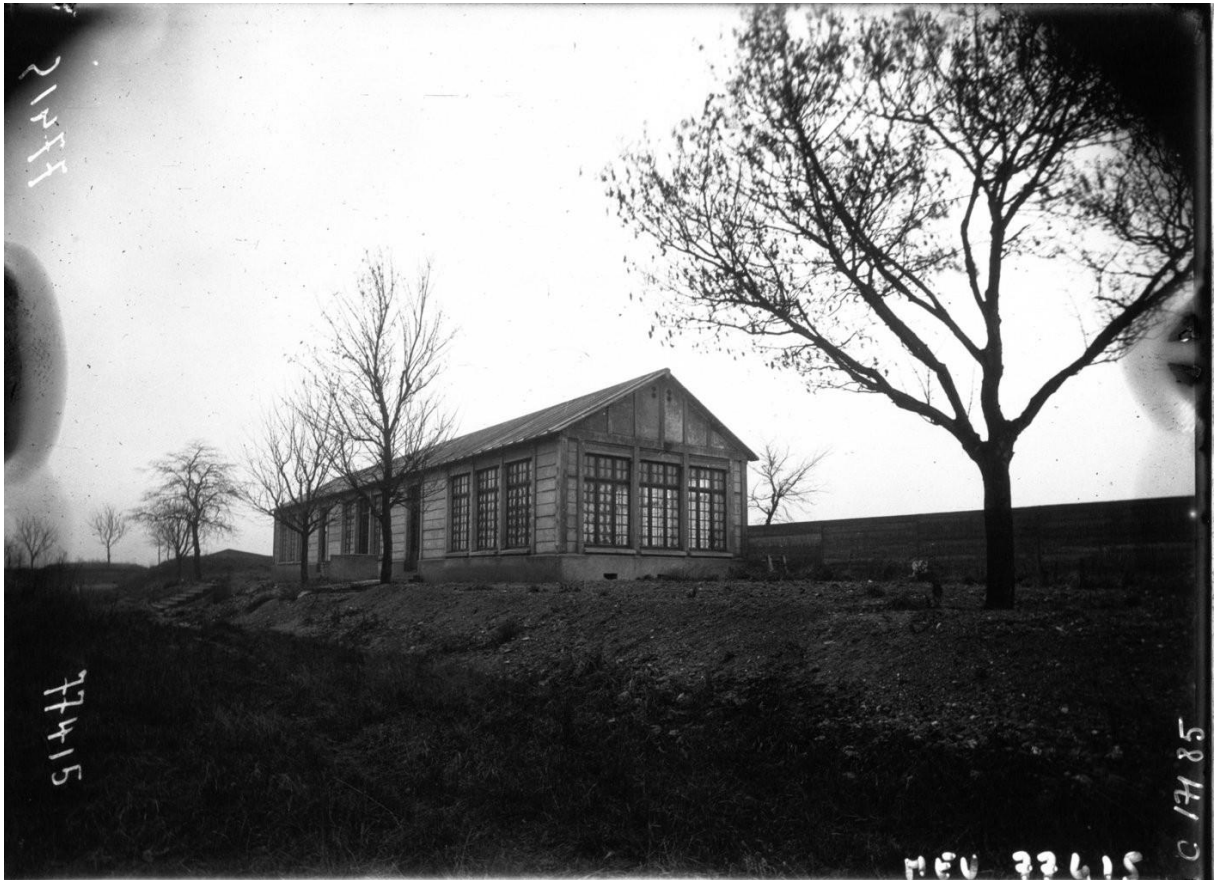
Figure 148 : Pavillon de l'école de plein air du boulevard Bessières, 1919. Paris : Agence de presse Meurisse. Notice disponible sur : http://gallica.bnf.fr/ark:/12148/btv1b9033280s/f1.item Les pavillons de la première école de plein air élevée en région parisienne après la Première Guerre mondiale sont directement issus des recherches conduites durant le conflit sur la préfabrication et la construction légère.
