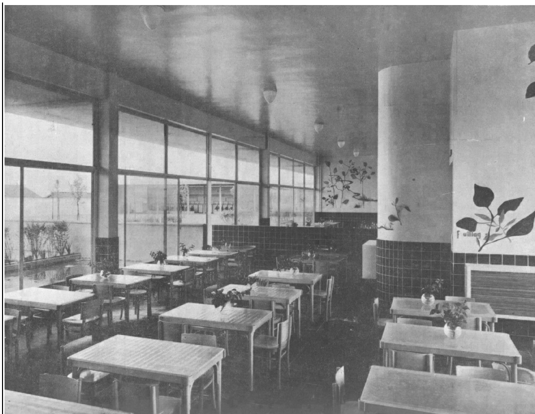
Figure 197 : Groupe scolaire Karl Marx, Villejuif (94), André Lurçat architecte, 1933. Photographie du réfectoire de l'école élémentaire de filles. In Le Béton Armé. Revue des systèmes Hennebique , mars 1934, 37 ème année, n°313, p. 1004.
