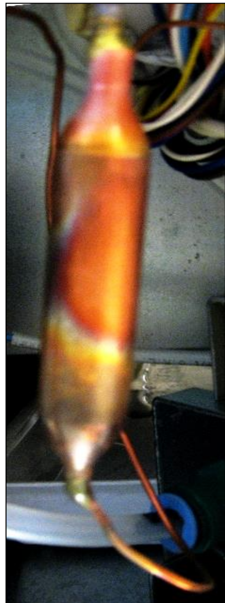
Figura 17: filtro disidratatore e tubo capillare
