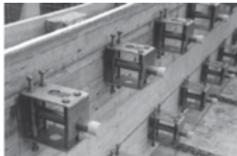
fig.9.87 d VISTA DEL CONNETTORE IN OPERA
