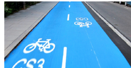
fig.4.10 CYCLE SUPERHIGHWAYS LONDRA Esempio di cycle superhighways
