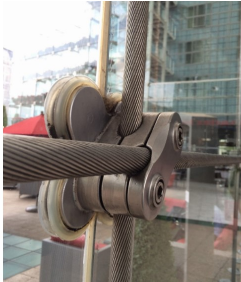
Figura 1.11: Morsetti di fissaggio dei pannelli di vetro alla rete di funi
