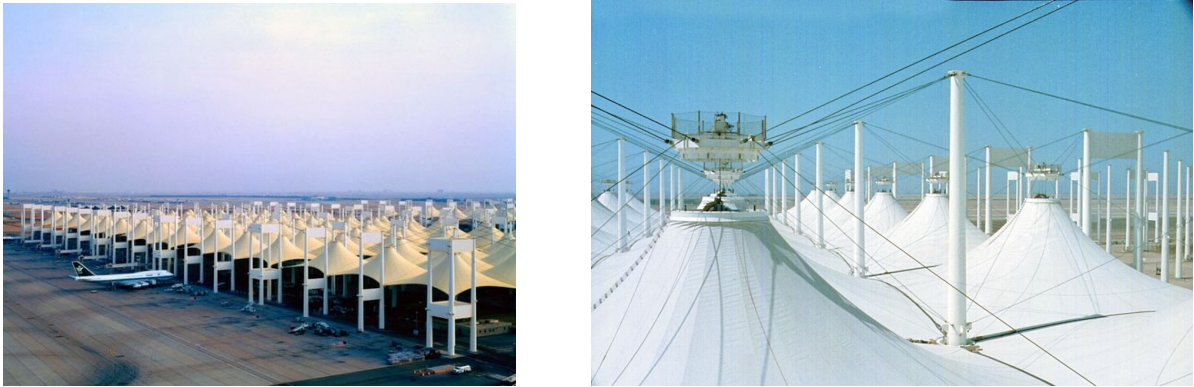
Figura 1.4: Copertura dell'aeroporto internazionale di Jeddah
