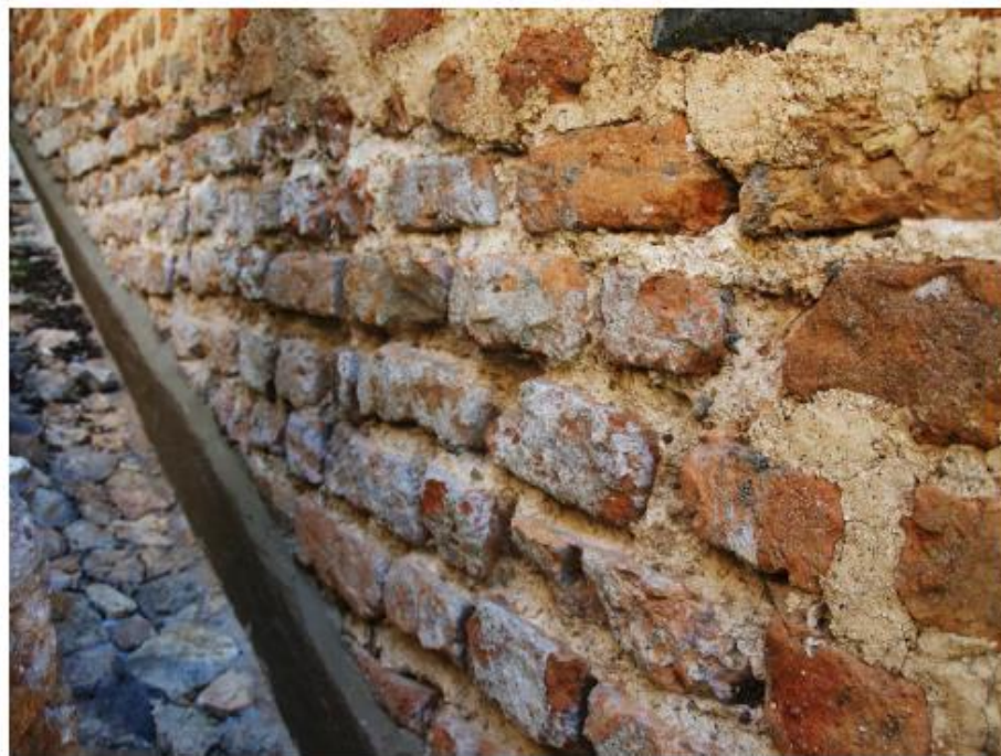
Figura 42-Scorcio della muratura lungo il canale di scolo del lato Ovest
