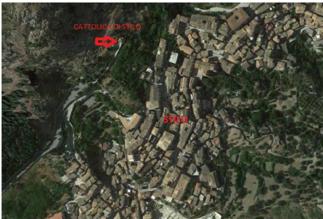
Figura 2-Visione aerea della Cattolica di Stilo
