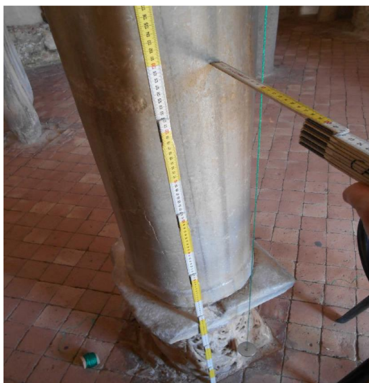
Figura 60 Misura della circonferenza della colonna a passi regolari di 20 cm
