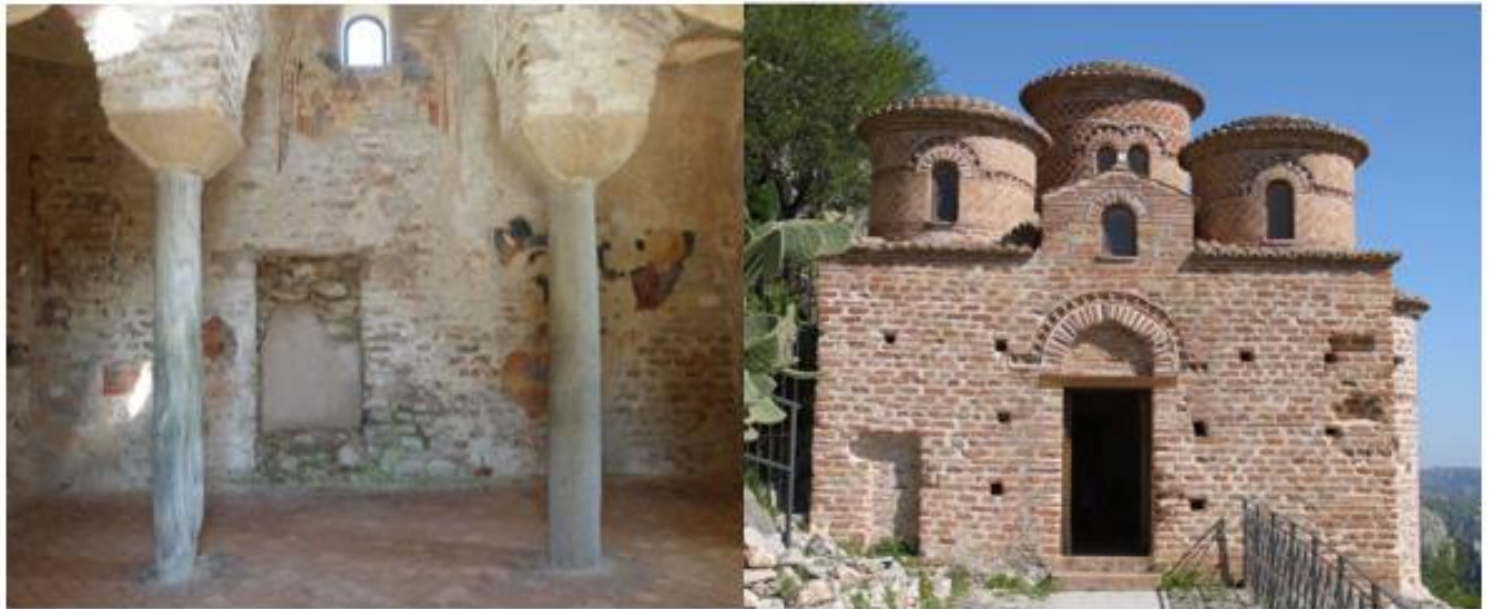
Figura 26-Dettagli delle aperture tamponate
