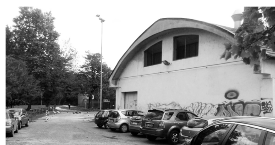
Magazzino - Vista dal lato nord
