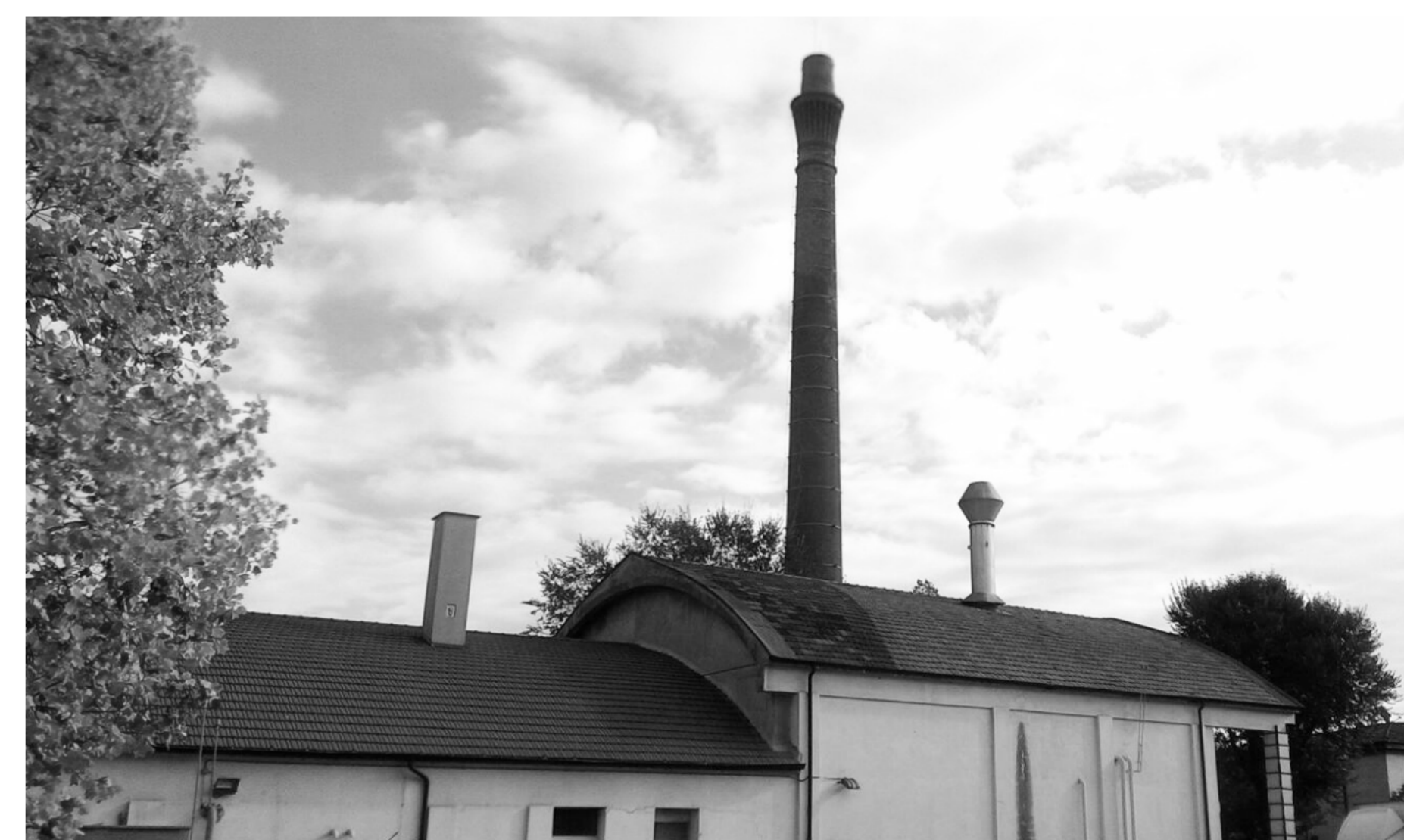
Magazzino - Vista dal lato sud-ovest
