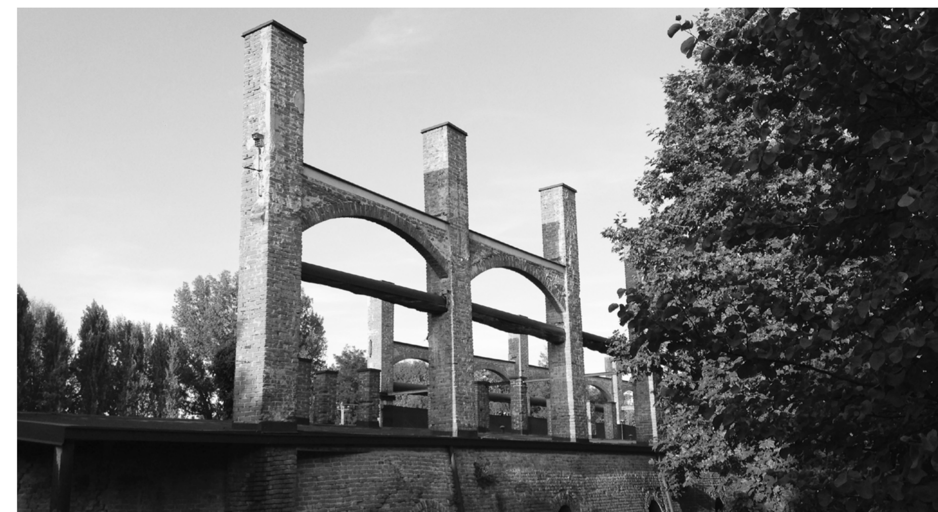
Fornace Frazzi - Stato attuale
