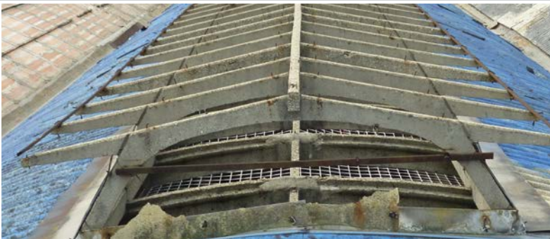
Fig. 52 Dettaglio copertura eternit
