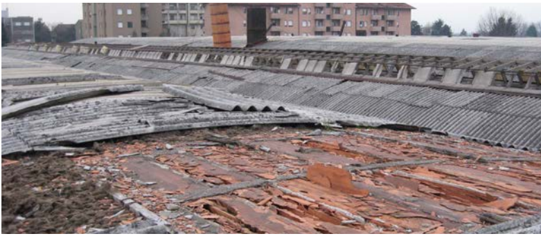
Figura 51 Dettaglio copertura eternit
