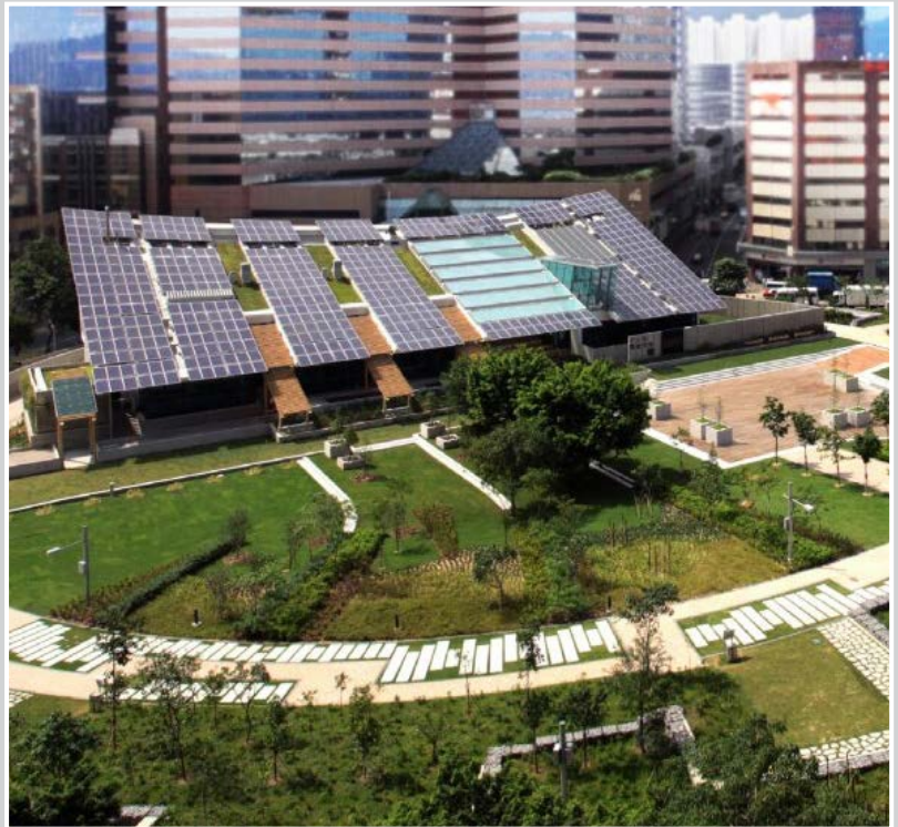
Figura 4 Vista esterna edificio
