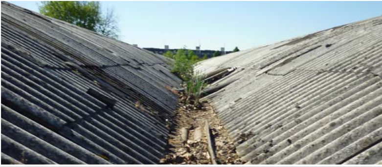
Figura 50 Dettaglio copertura eternit
