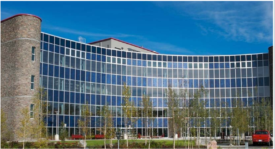
Figura 2 Vista della facciata
