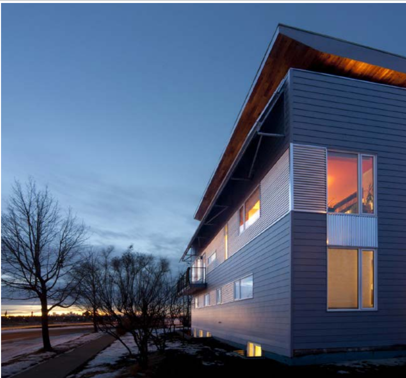
Figura 1 Vista esterna edificio
