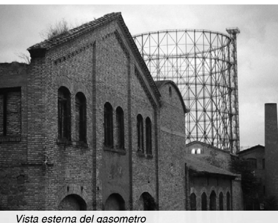
Vista esterna del gasometro
