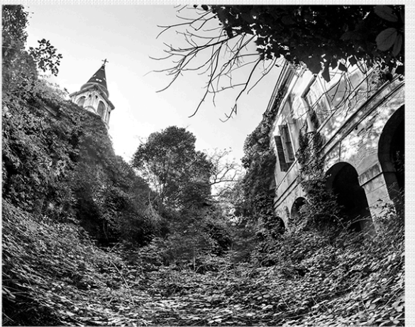
FOTOGRAFIA ATTUALE edifici principali che sono stati usati nel passato come: forte di salinatura, pesca ed agricoltura, rifugio, convento, lazzaretto, stazione di sanita' marittima e ospedale geriatrico Bando del concorso YAC
