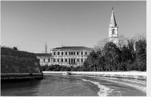
FOTOGRAFIA ATTUALE bacino di poveglia ed edifici principali Bando del concorso YAC
