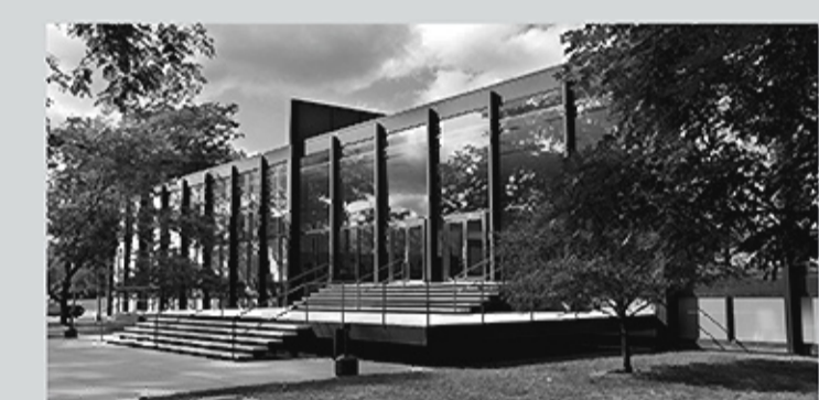
CROWN HALL - CHICAGO - MIES VAN DER ROHE - 1956
