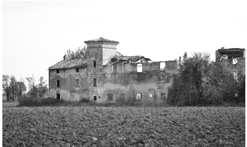
Veduta del fronte nord, dall'accesso stradale
