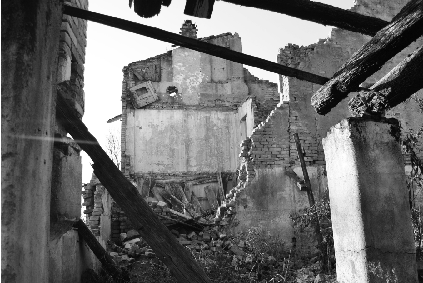
Dettaglio sullo stato di abbandono
