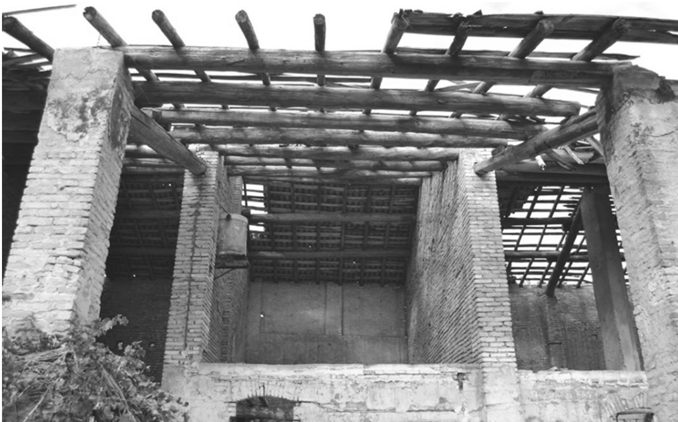
Dettaglio del tetto del fienile
