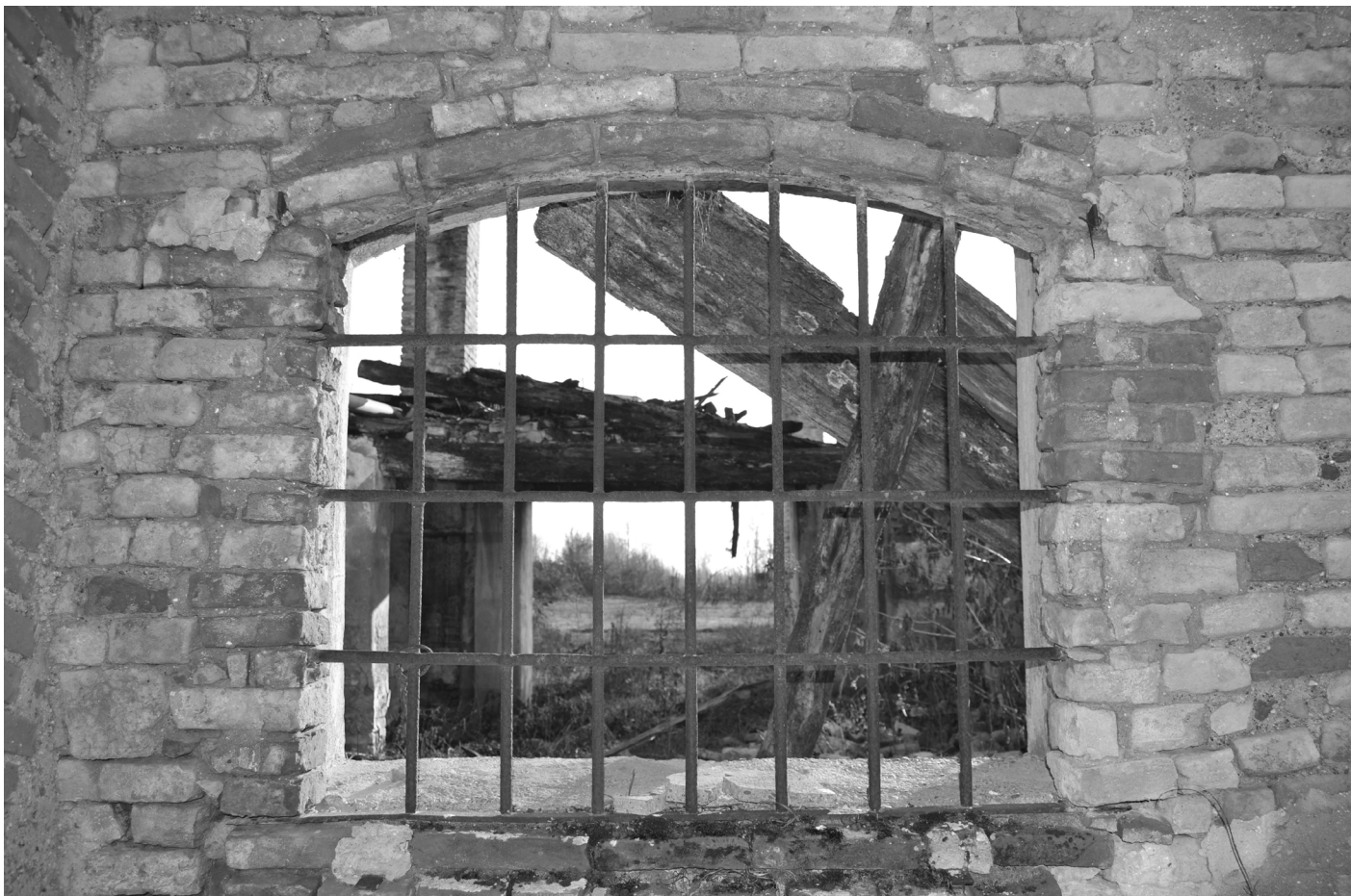
Dettaglio sulle aperture del fronte nord
