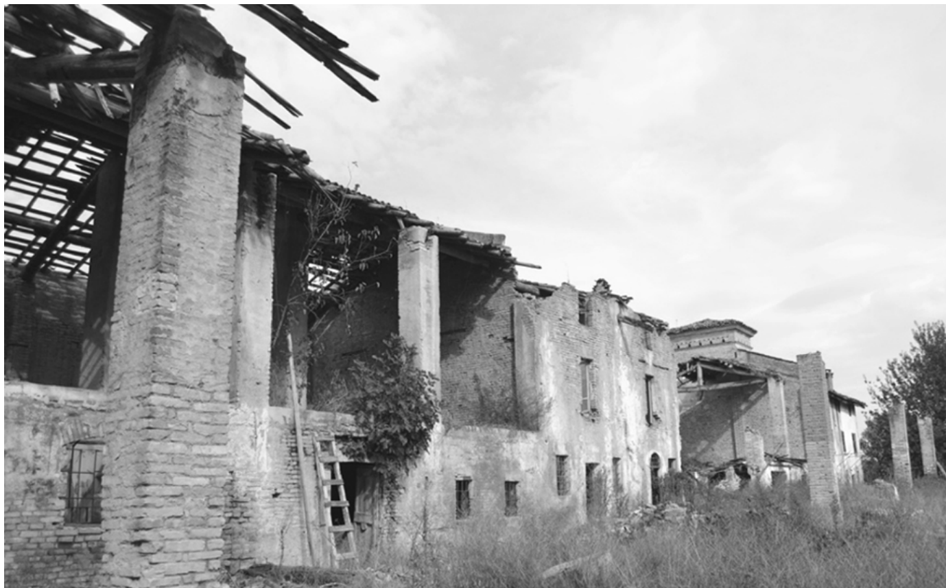
Veduta del lato sud, dall'accesso stradale
