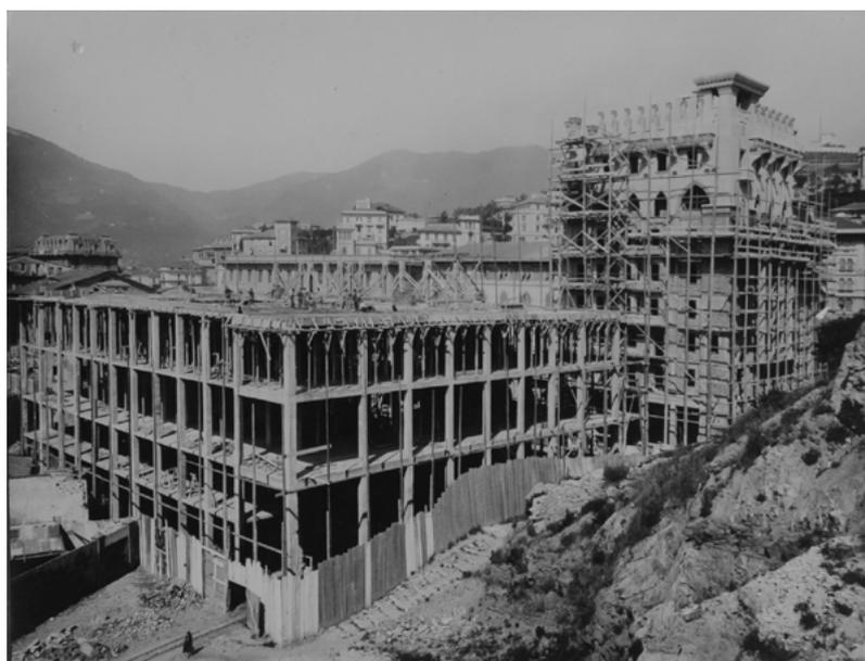
Foto d'epoca che ritrae il Palazzo del Governo e il Grattacielo, entrambi in costruzione. Sulla destra si vede ancora l'altura del Colle dei Cappuccini. Fotografia d'archivio dell'impresa Ferrari, 31 dicembre 1926
