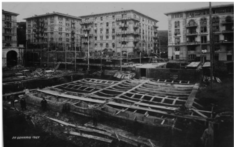
Foto storica che documenta la costruzione del Palazzo degli Studi della Spezia, in cui è possibile recuperare informazioni sulla tecnica costruttiva, in questo caso le fondazioni sono state costruite a platea con travi rovesce. Fotografia d'archivio dell'impresa Ferrari, 20 gennaio 1927
