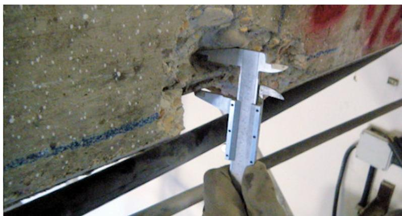
Il calibro può essere molto utile come strumento per rilevare piccole parti, in particolare per misurare degli spessori in dettaglio. In questo caso è rappresentato il delle armature di una trave scoperta.
