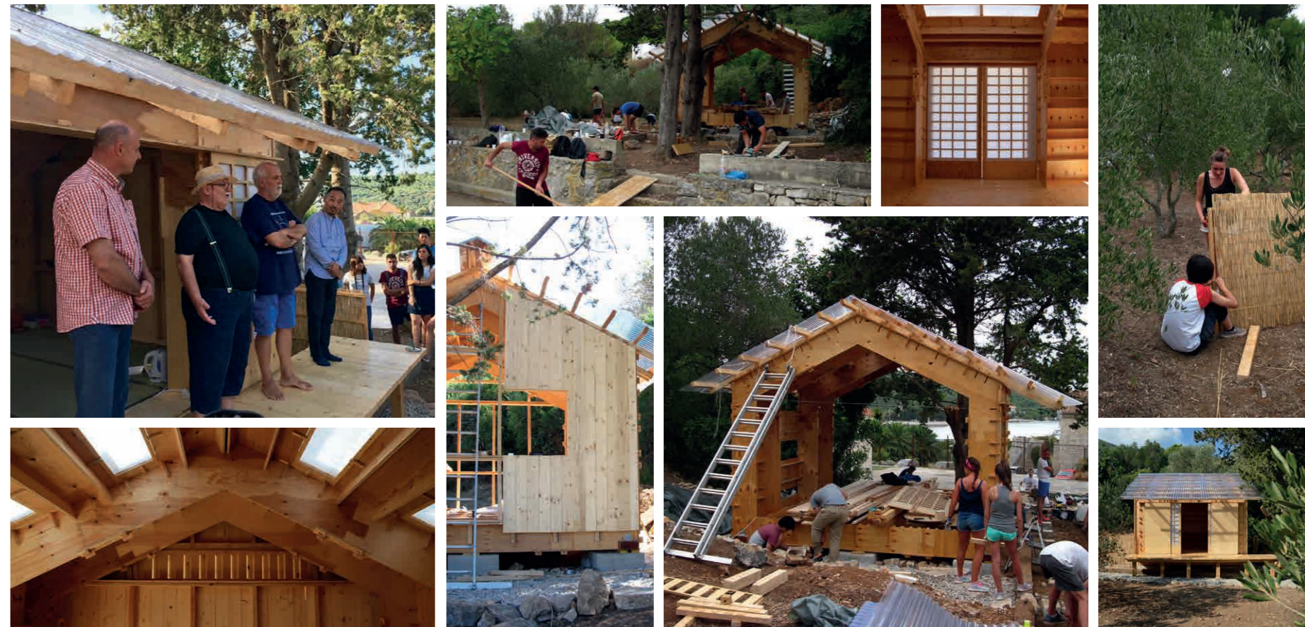
Figura 526_Costruzione del Childrens' Pavillion, Vis, Croazia
