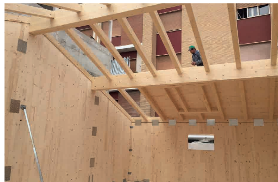
Figura 111_Esempi di costruzioni in Cross-Lam durante le fasi di cantiere
