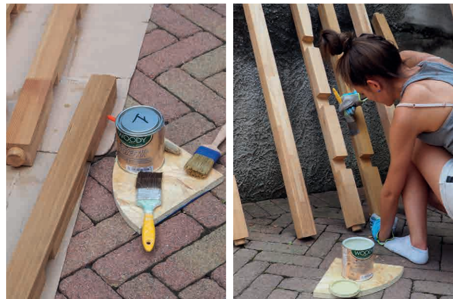
Figura 249_Impregnazione e finitura dei travetti in legno di larice
