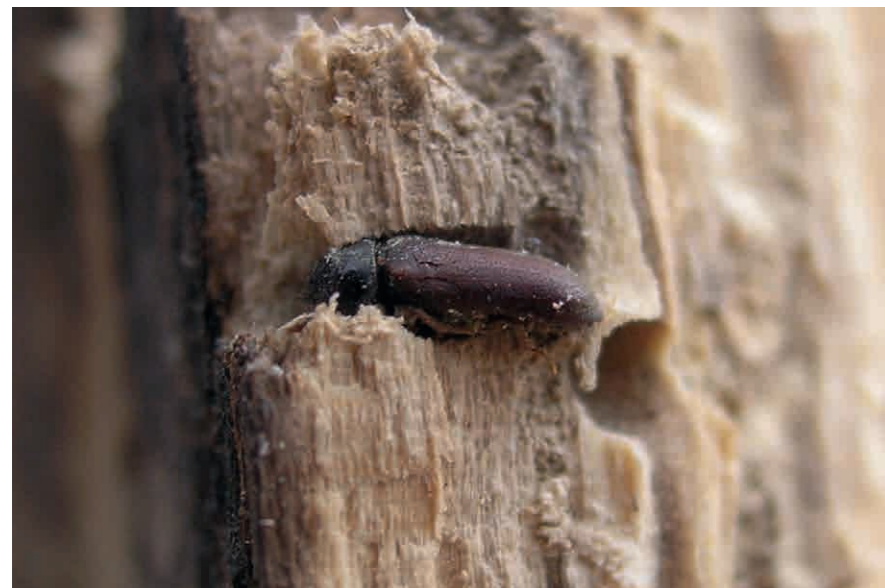
Figura 102_Attacco del legno da parte degli insetti
