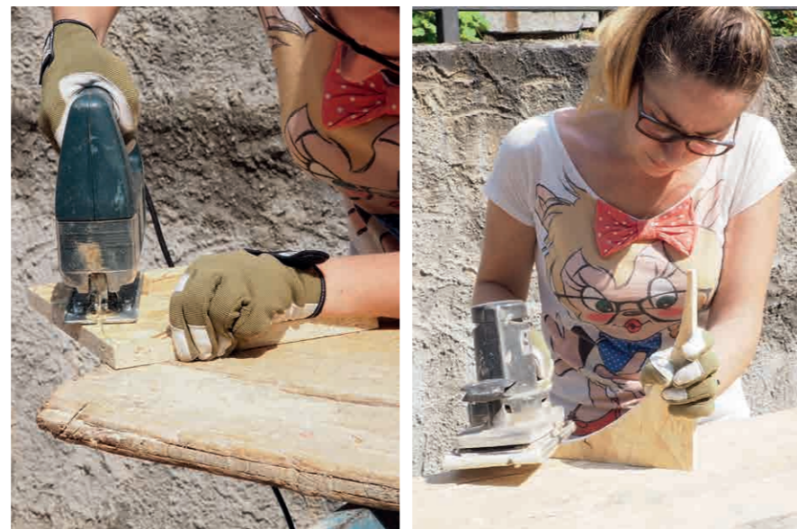
Figura 250_Taglio e levigatura dei pannelli OSB
