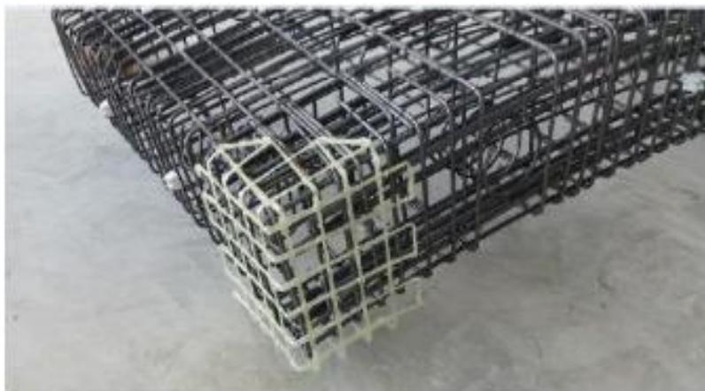
**Figura 184 Esempio Di Armatura Di Rinforzo In VTR Dello Spigolo**
