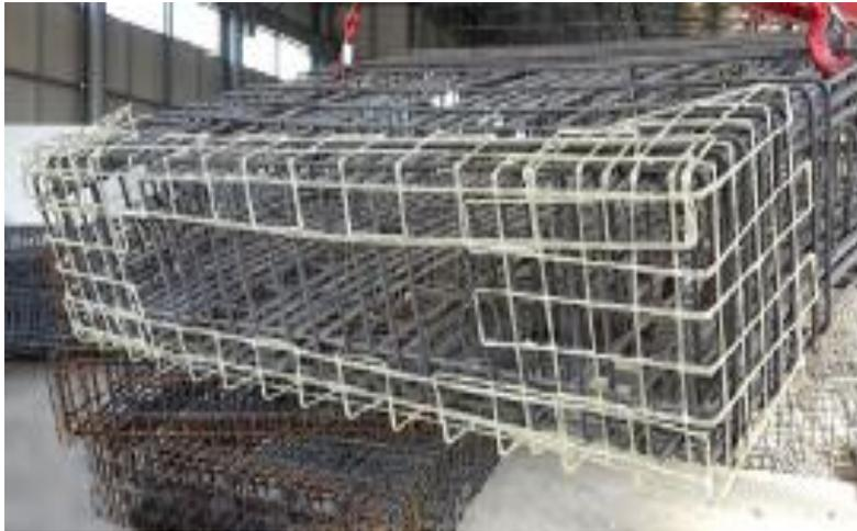
**Figura 183 Esempio Di Armatura Di Rinforzo In VTR Dello Spigolo Vista Laterale**
