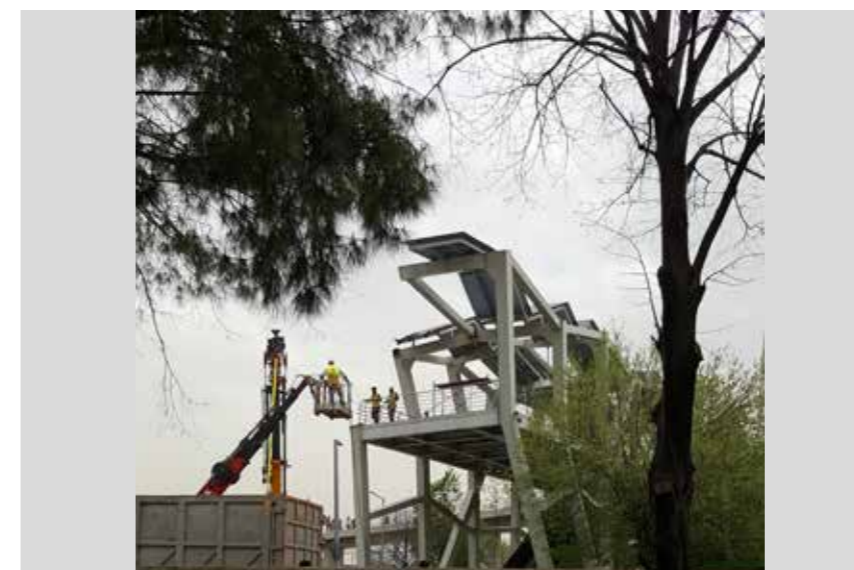
Fig. 2.09 Demolizione del ponte
