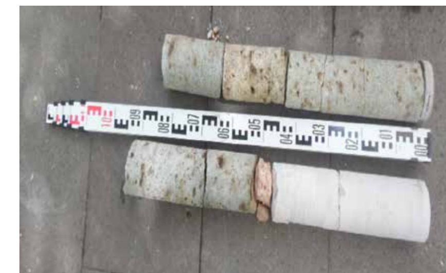
Fig. 7.67 Campione di parete ottenuto tramite carotaggio.
