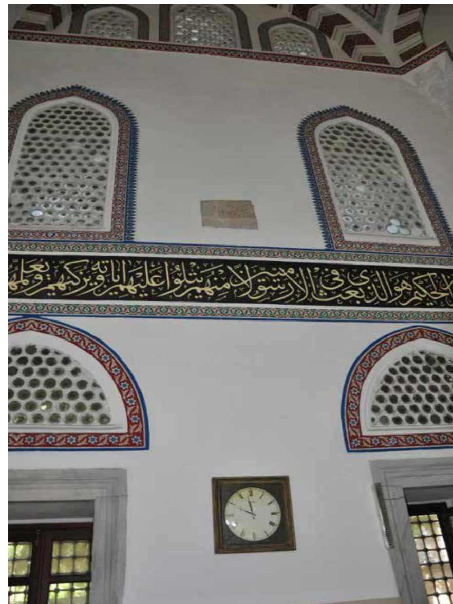
Fig. 7.59 Raschiamento di intonaco a base di malta cementizia nella parte alta dell'Harim
