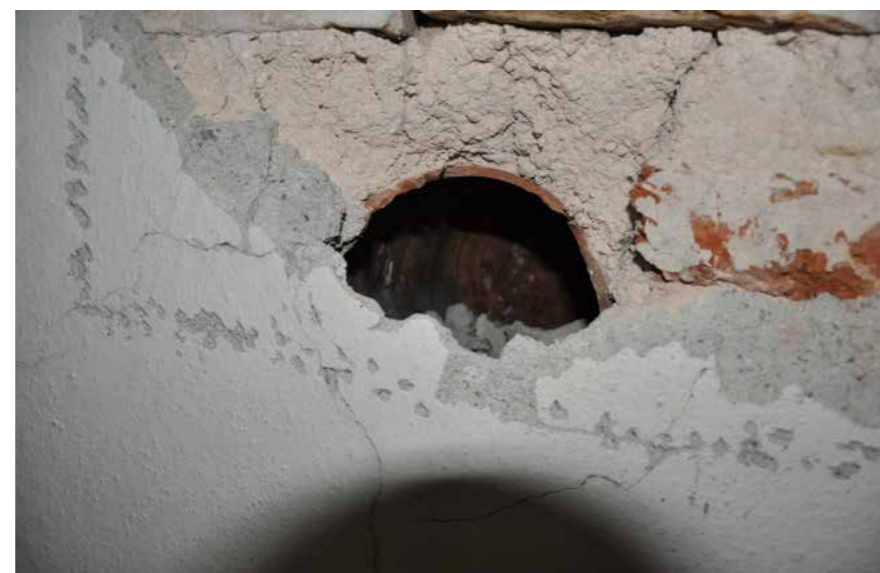
Fig. 7.61 Rimozione degli intonaci vicino la cupola
