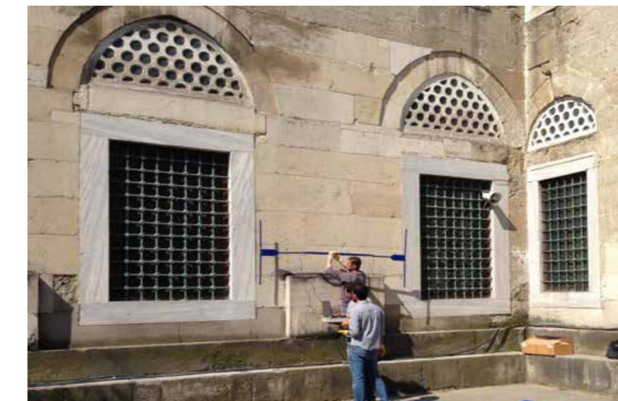
Fig. 7.66 Rilievo fotografico campagna diagnostica GRD
