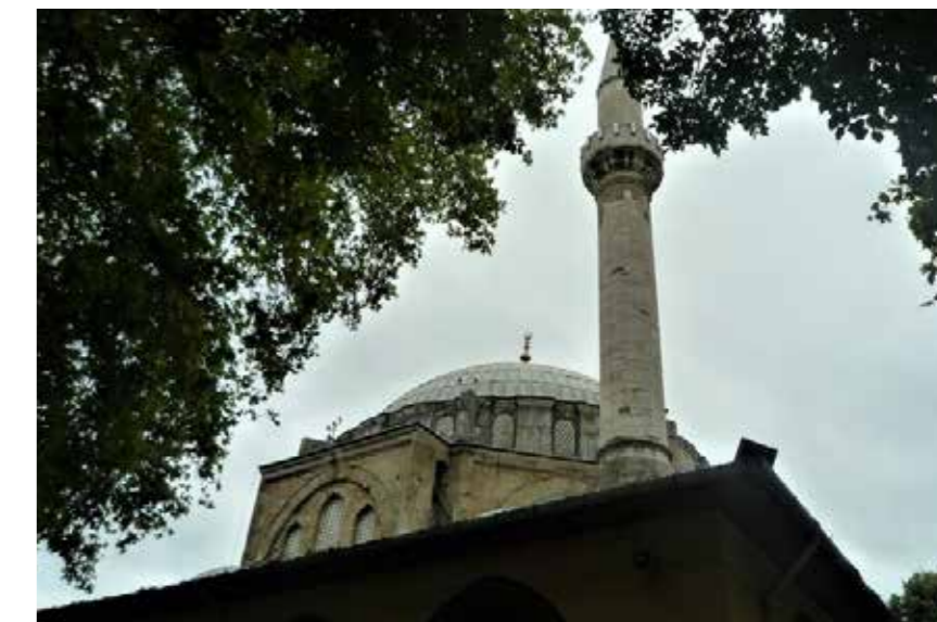
Fig. 7.10 Vista del minareto
