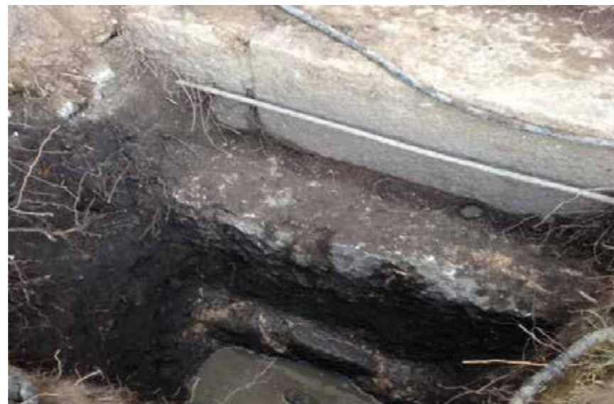
Fig. 7.56 Rilievo fotografico Indagine fondazione lato Sud
