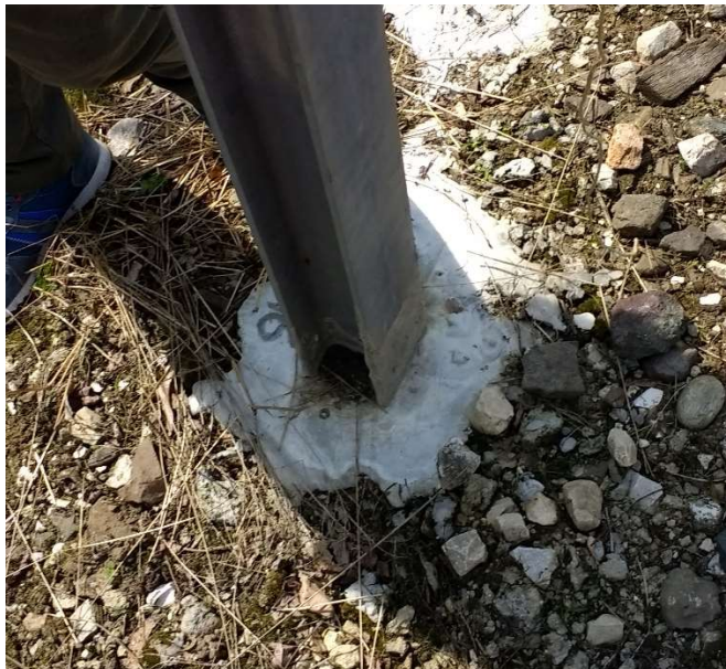
Figura 4-E Dettaglio- inserimento malta cementizia
