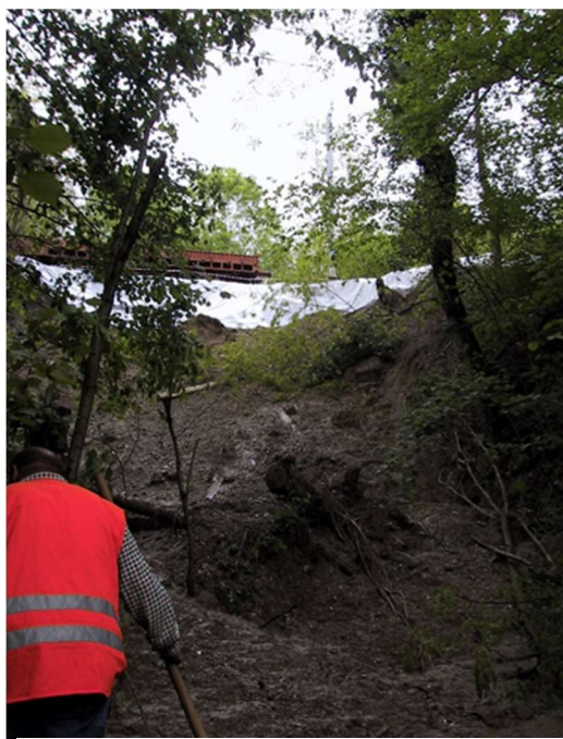
Figura 1.1-B Frana Luvinate 2002-vista dal basso
