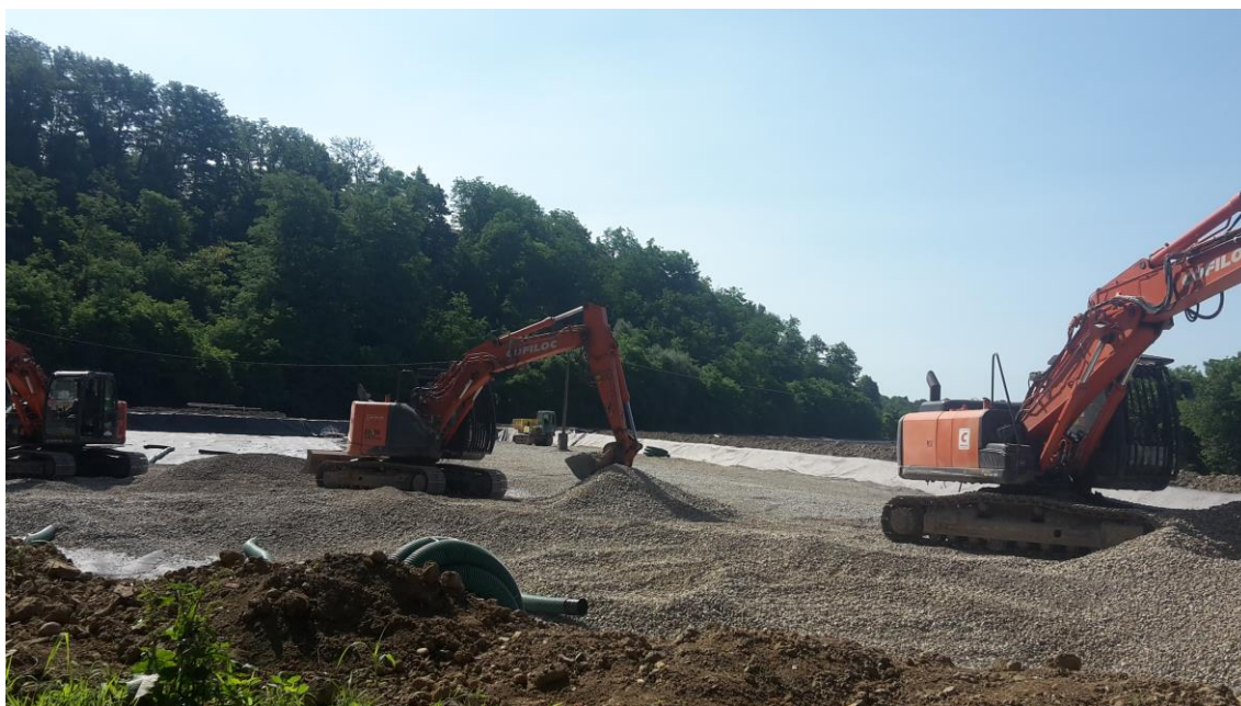
Figura 4.9: distribuzione del materiale inerte di riempimento lungo tutta l'area del bacino
