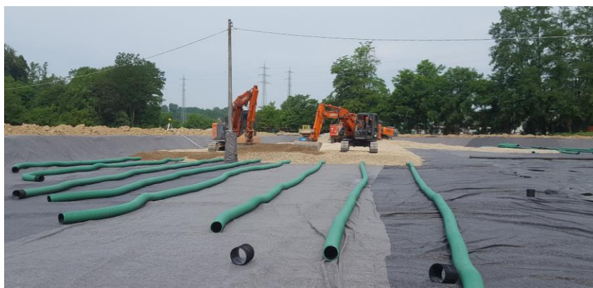
Figura 4.8: stesa delle tubazioni di drenaggio nel bacino 1
