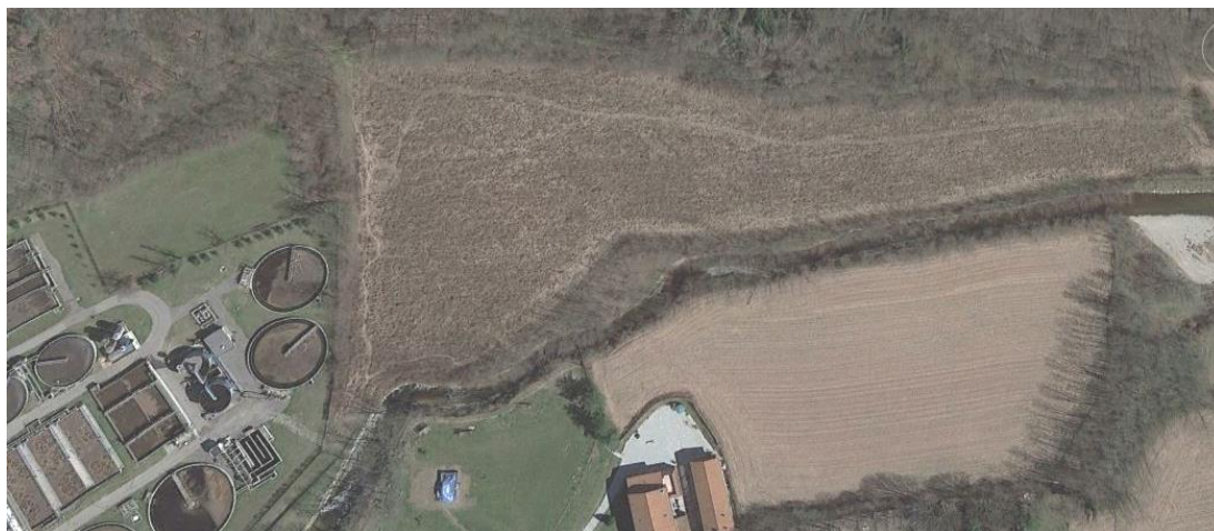
Figura 2.6: situazione dell'area di cantiere prima dell'inizio delle opere
