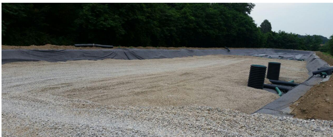
Figura 4.11: strati di riempimento completi del bacino 2 e particolare della tubazione magnum a riporto del misuratore li livello
