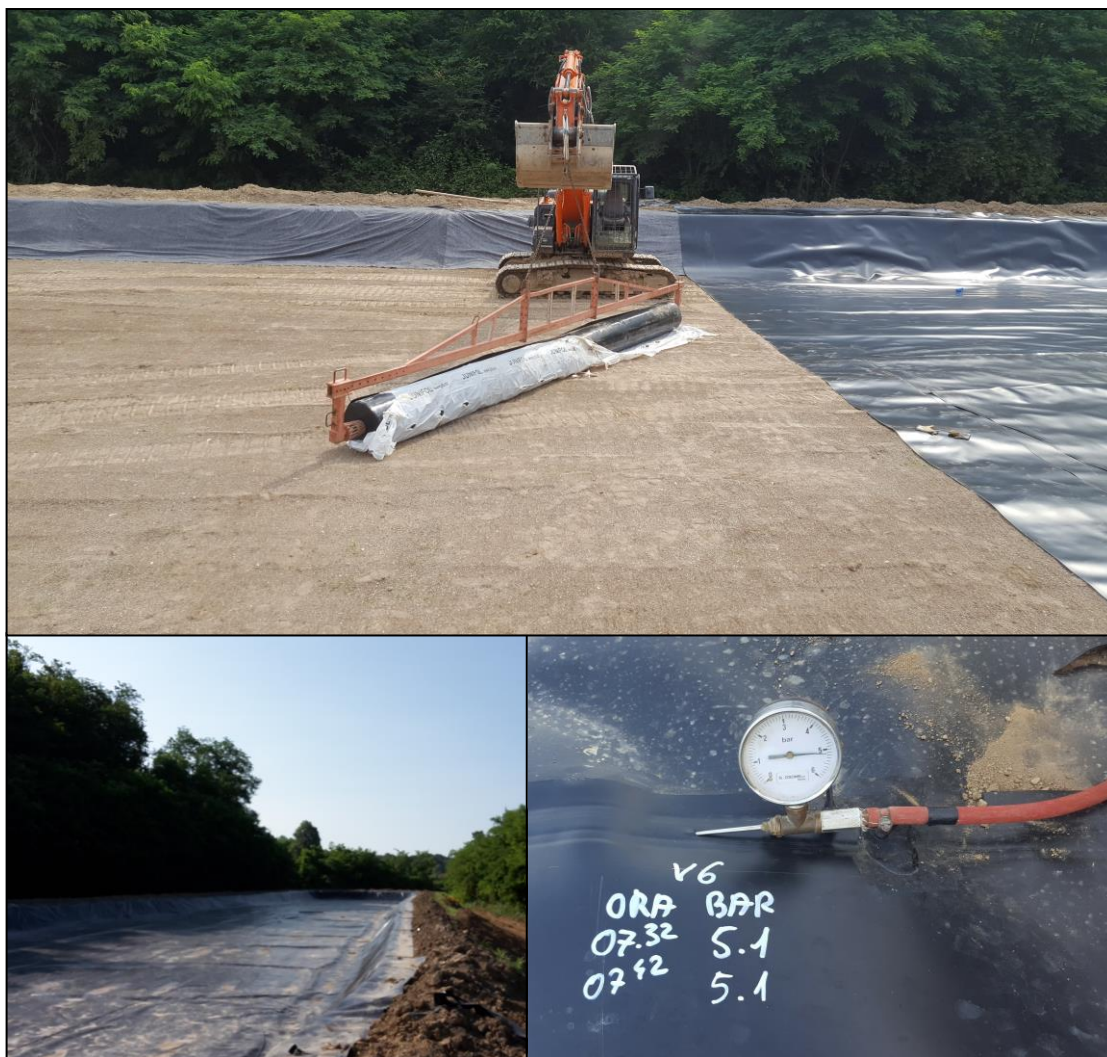
Figura 4.7: geomembrana posata sul bacino 2 ed esempio di verifica alla saldatura E' stato possibile, una volta posate le tubazioni di drenaggio, iniziare con il riempimento di questi bacini partendo da inerte con granulometria elevata e procedendo per gradi fino a granulometrie molto fine (fino a valori di 1-5 mm di diametro).
