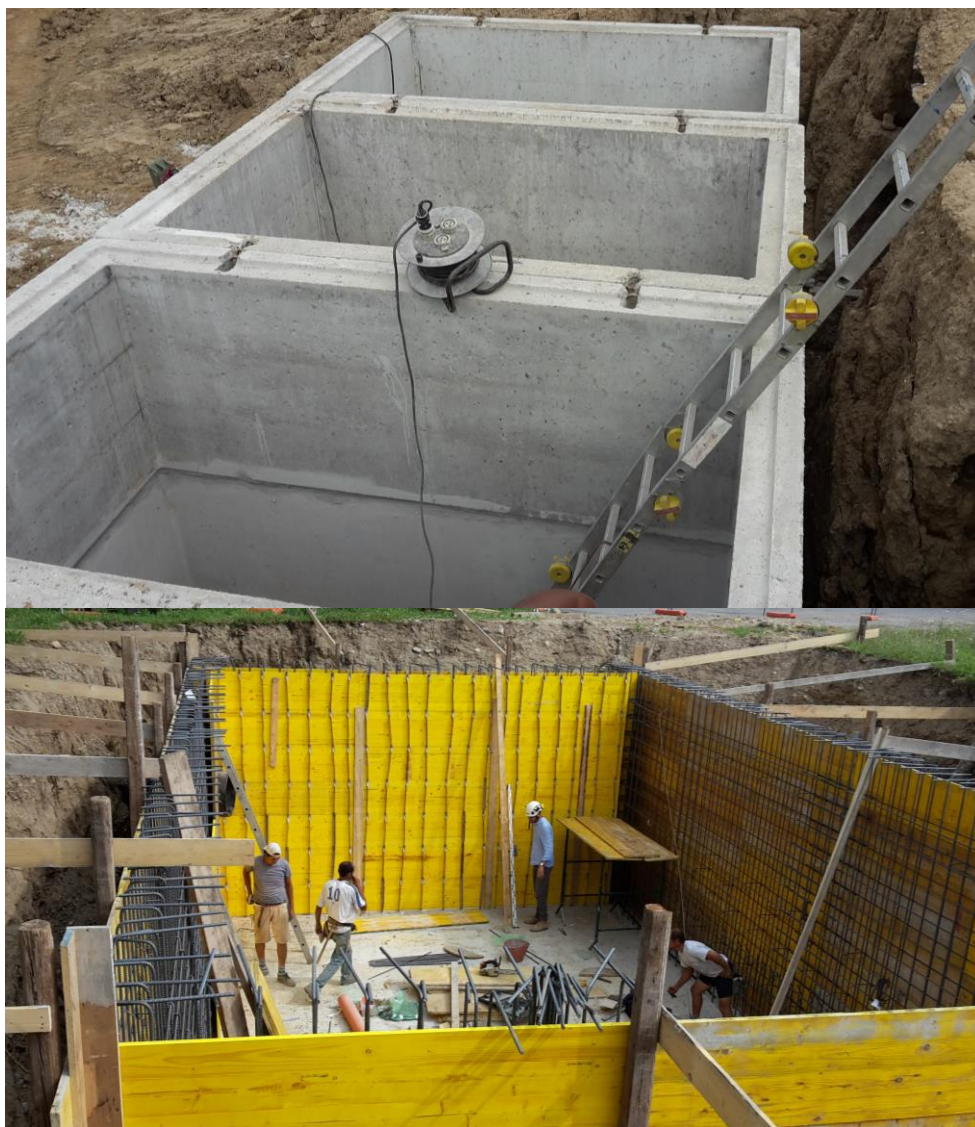
Figura 4.13: opere in cemento armato
