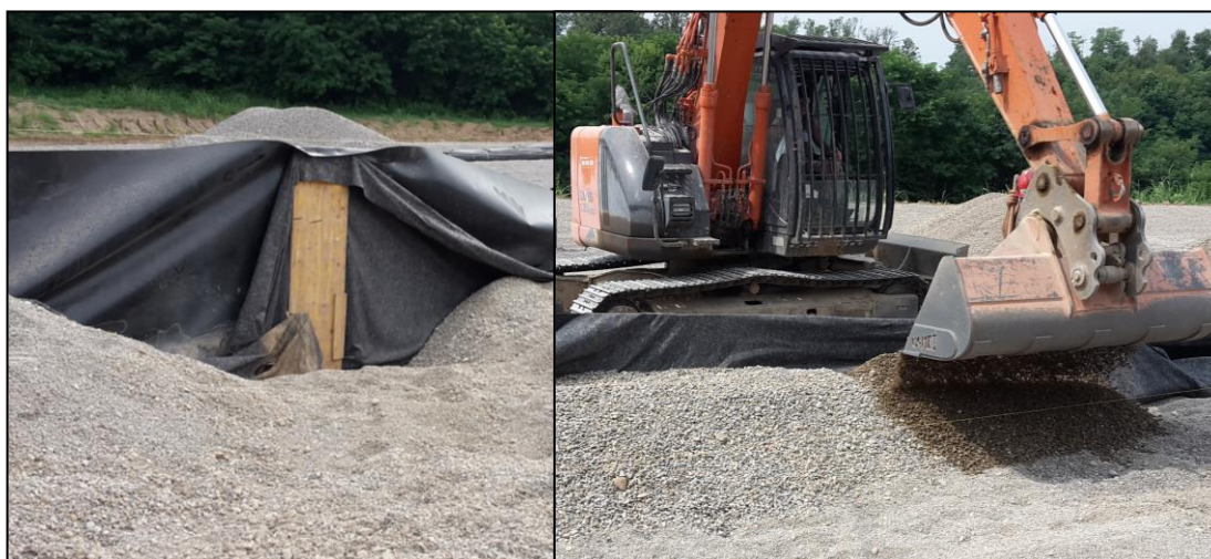
Figura 4.15: particolare del telo impermeabile di divisione dei sottobacini e relativa lavorazione
