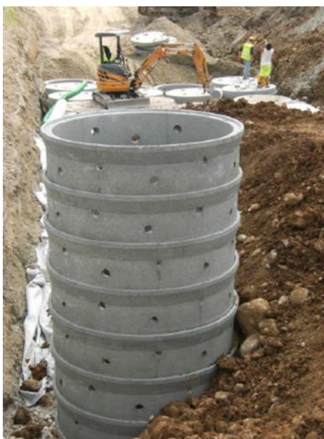
Figura 8.6. Pozzo in calcestruzzo forato in cui vengono inserite le tubazioni verticali del sistema di intercettazione del biogas
