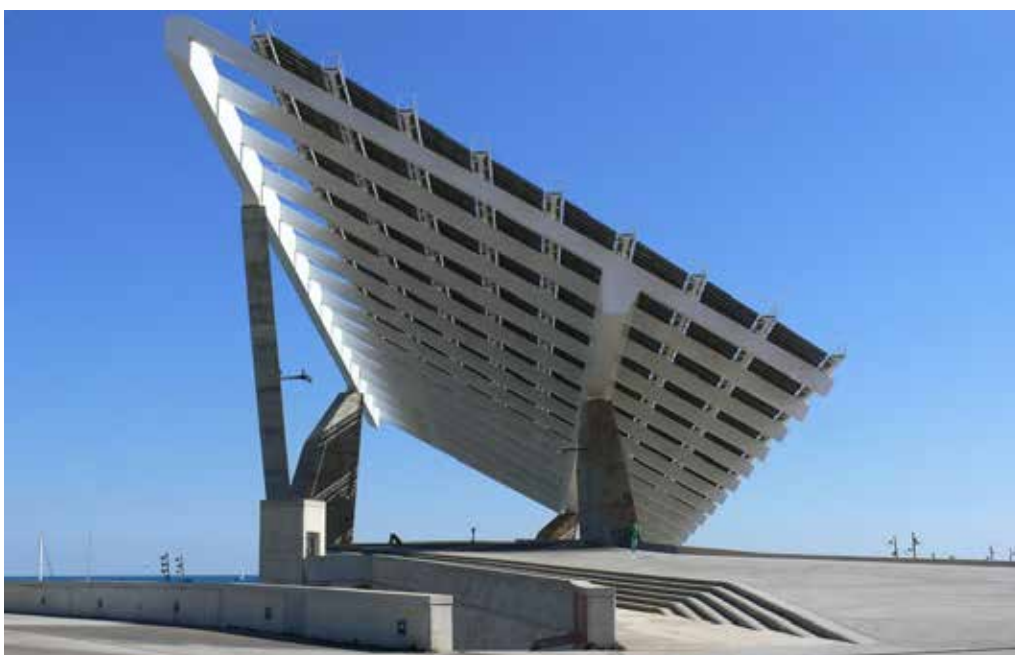
Figure 3.5 Barcelona - Placa fotovoltaica del Fòrum
