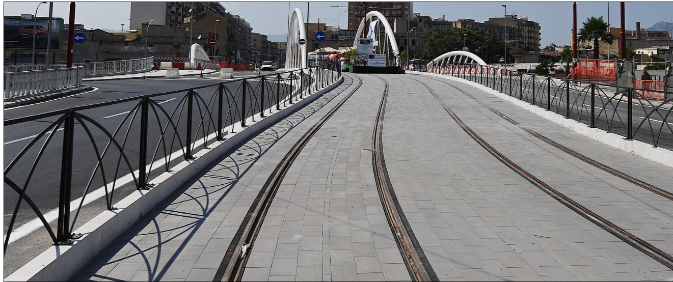
Nuovo ponte sull'Oreto [118] ← www.livesicilia.it
