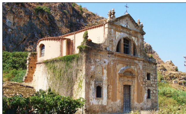
Chiesa di Mare dolce [107] ← www.balarm.it
