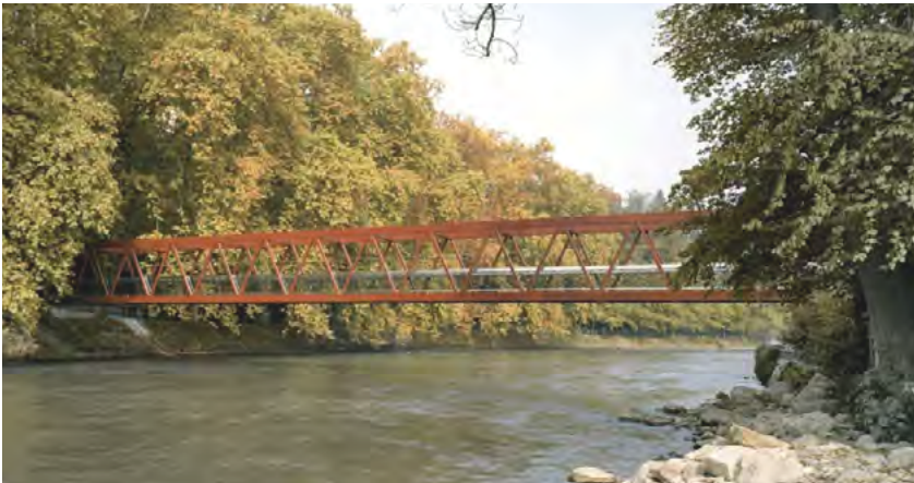
Limmat Footbridge, Svizzera
