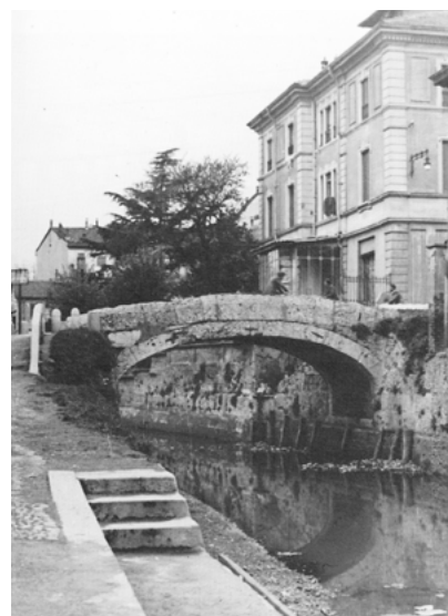
F.2.1.7 - Ponte Vecchio a Gorla, 1830
