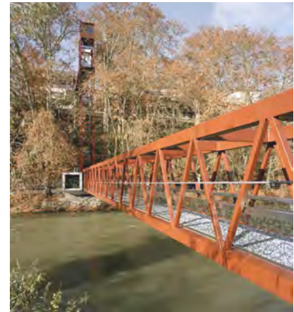
Limmat Footbridge, Svizzera
