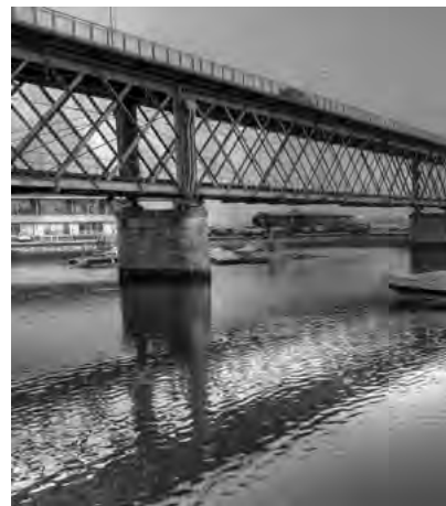
F.2.5.6.3 - Ponte Eiffel, Gustave Eiffel, Portogallo
