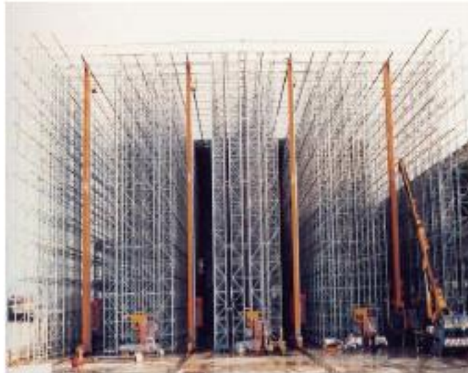
Figura 1.11: Magazzino autoportante in doppia profondità
