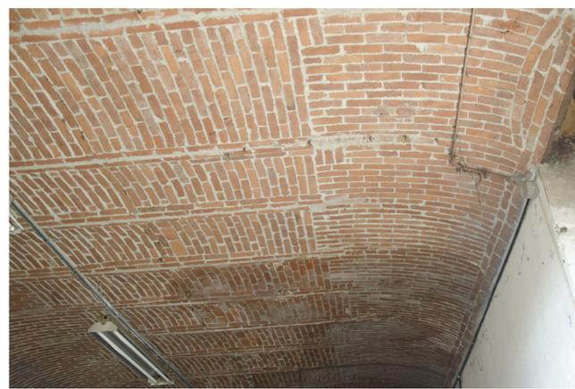
foto stato di fatto ala ovest e particolare volta a schifo
