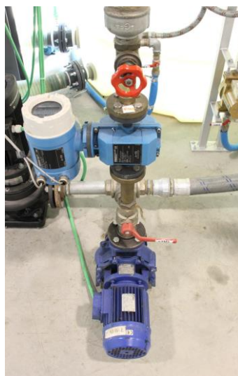
Figura 3.5: Pompa centrifuga e misuratore di portata d'acqua [4]
