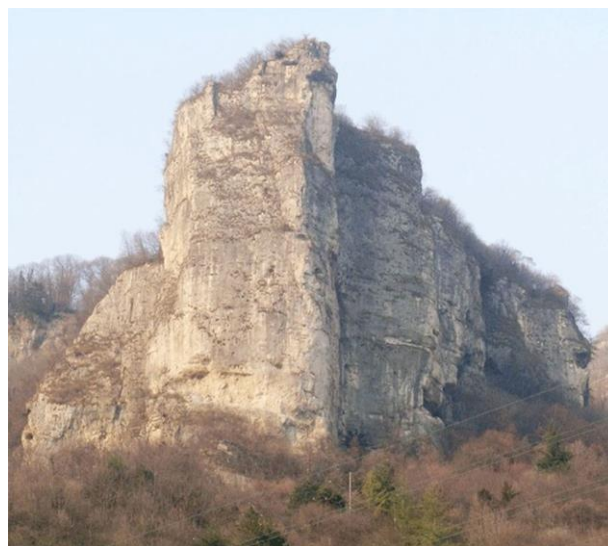
Figura 3.5 Vista dei Torrioni di Rialba: è possibile notare la linea elettrica e la zona di debolezza alla base Fonte (Brambilla et al., 2017)
