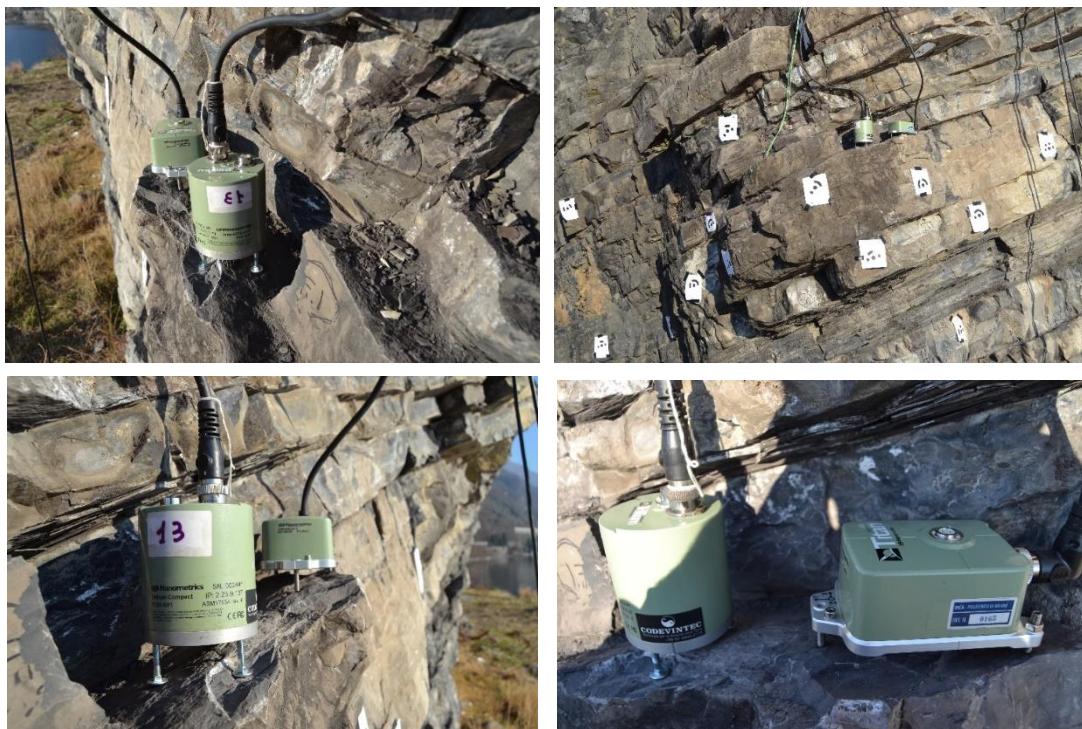
Figura 4.25 Posizionamento sensori sul blocco instabile
