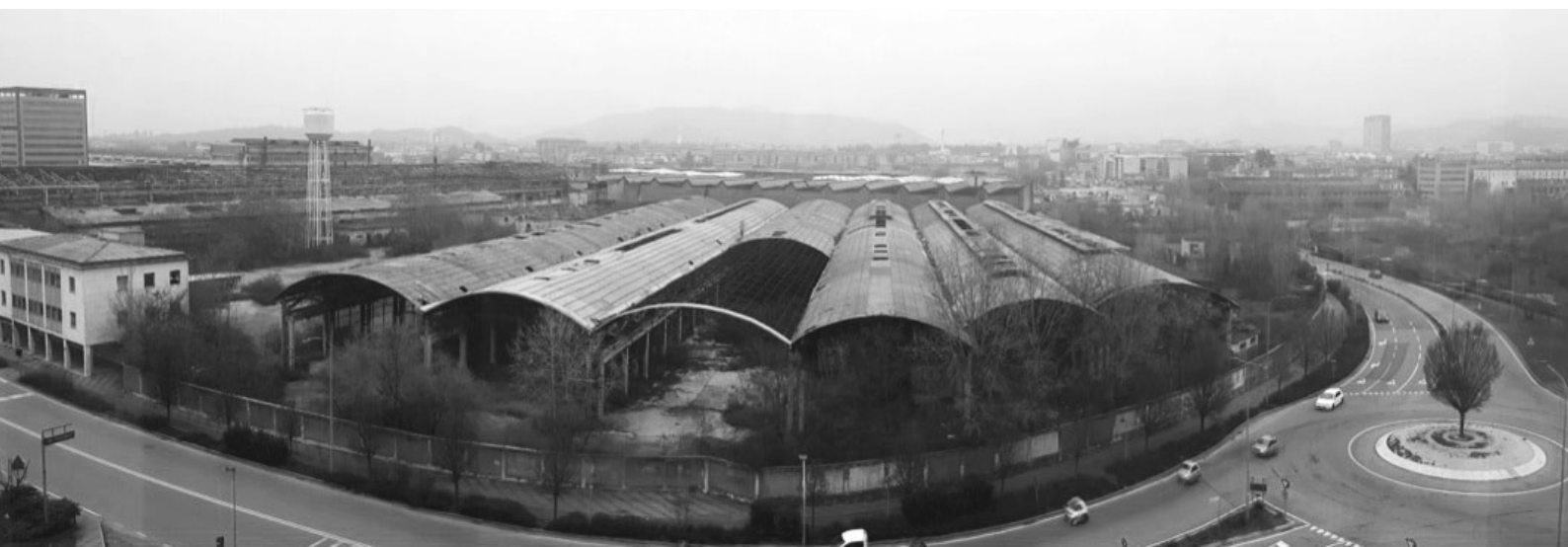
Figura 2.21 - Coperture amianto area Pietra Curva
