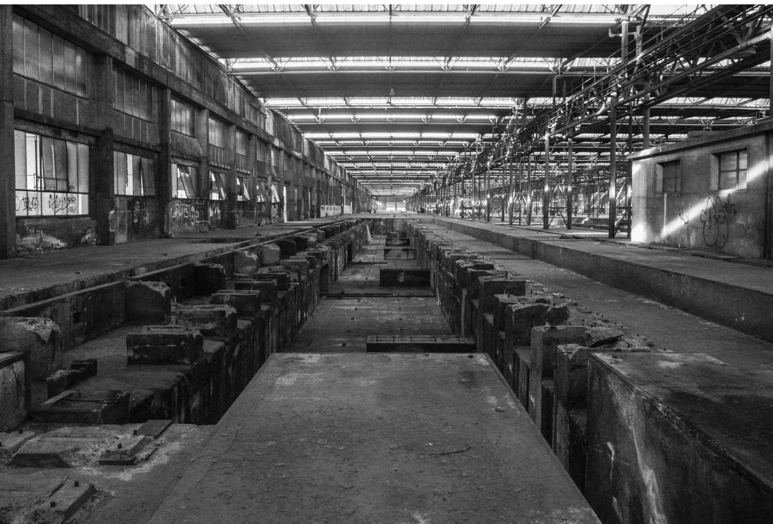
Figura 3.15 - Tubificio, vista interna
