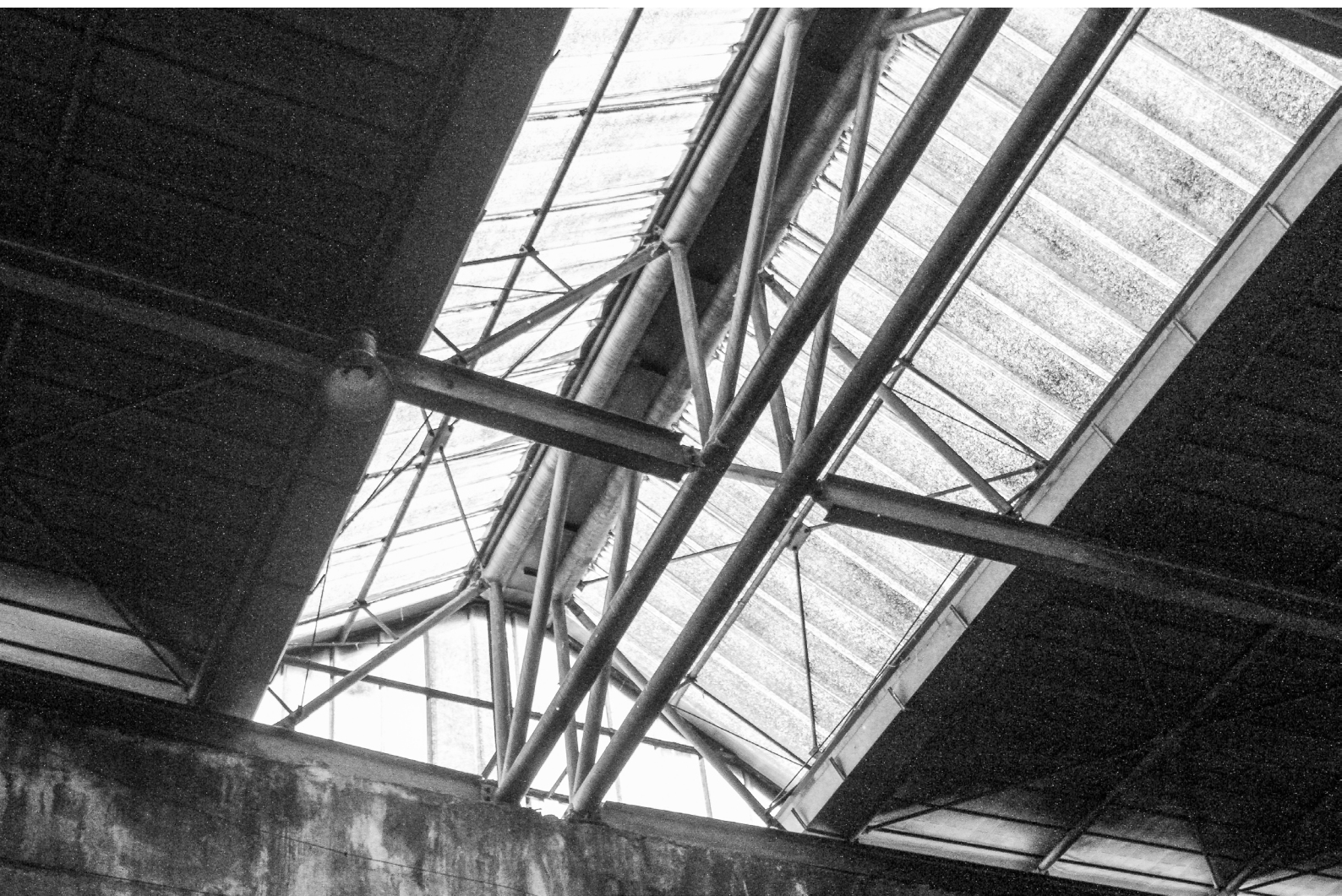
Figura 9.2 - Struttura reticolare esistente sottostante i lucernari
