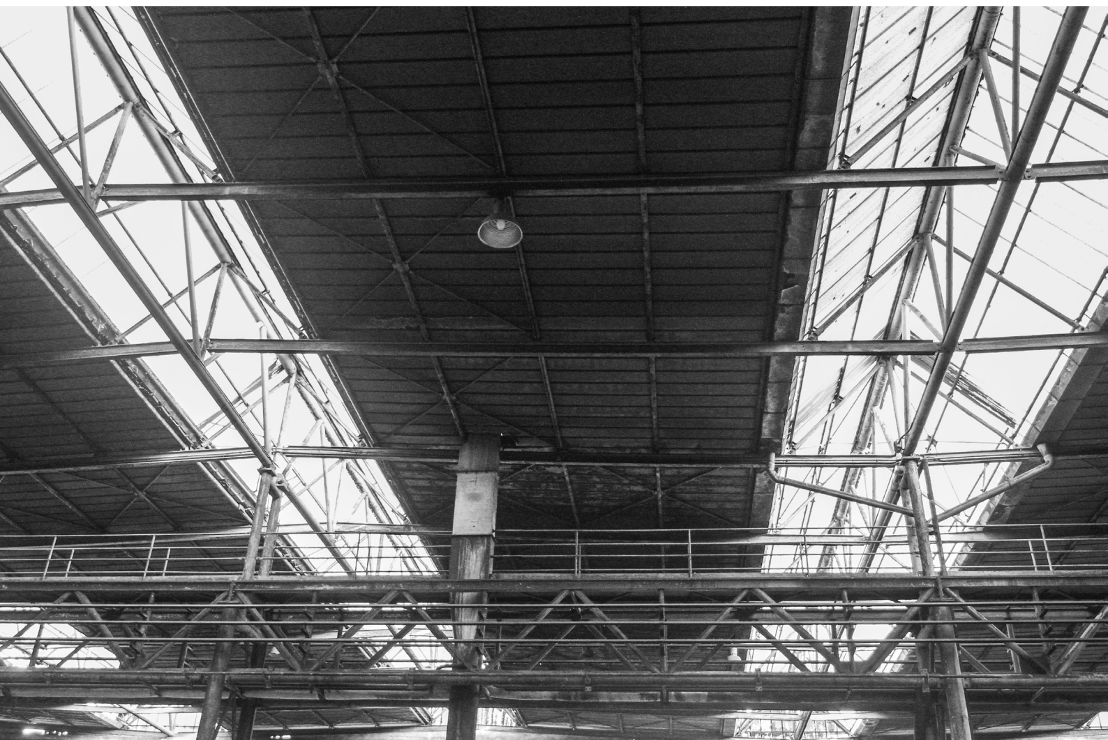
Figura 9.10 - Copertura esistente in lamiera metallica
