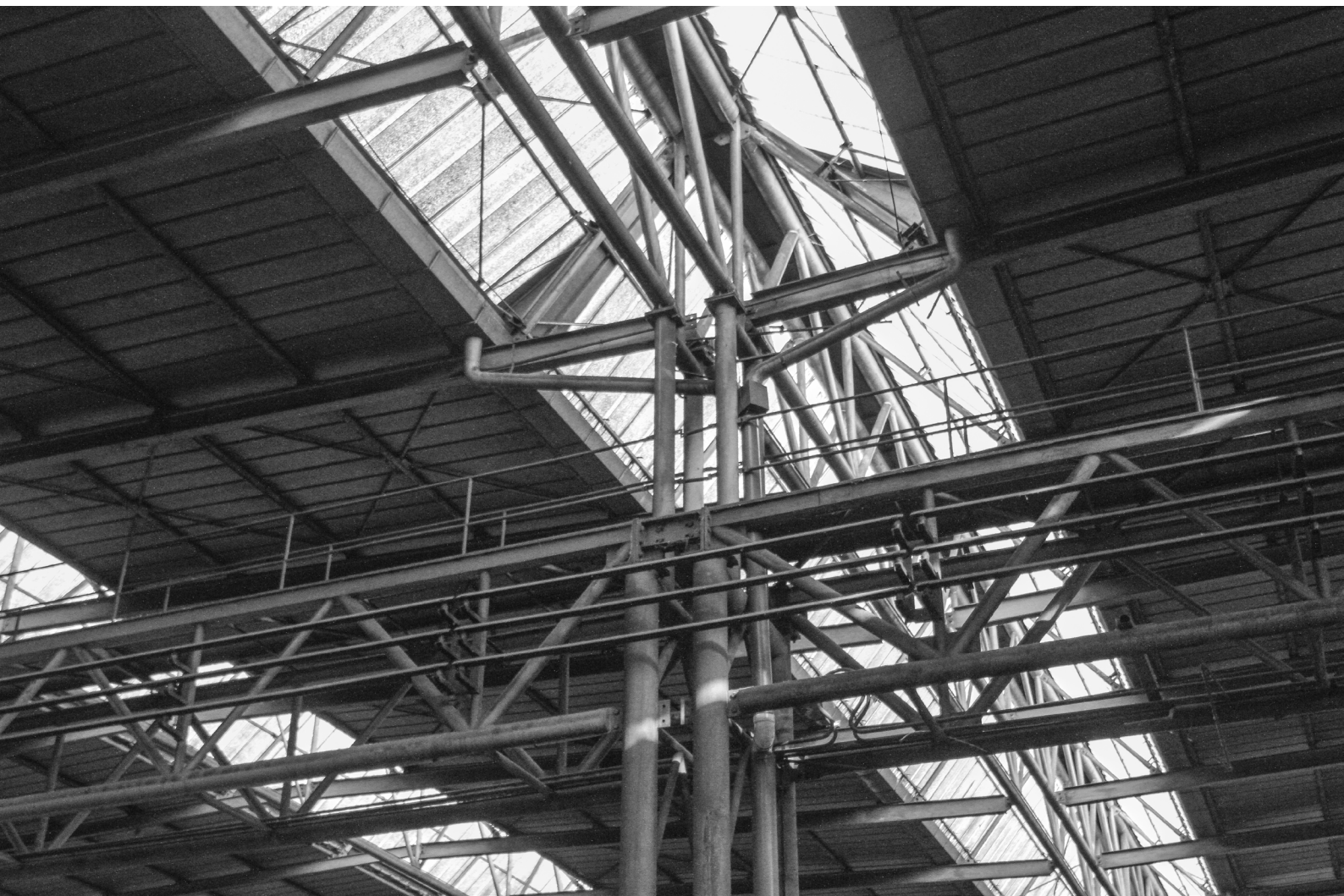
Figura 9.13 - Strutture reticolari ortogonali superiore ed inferiore
