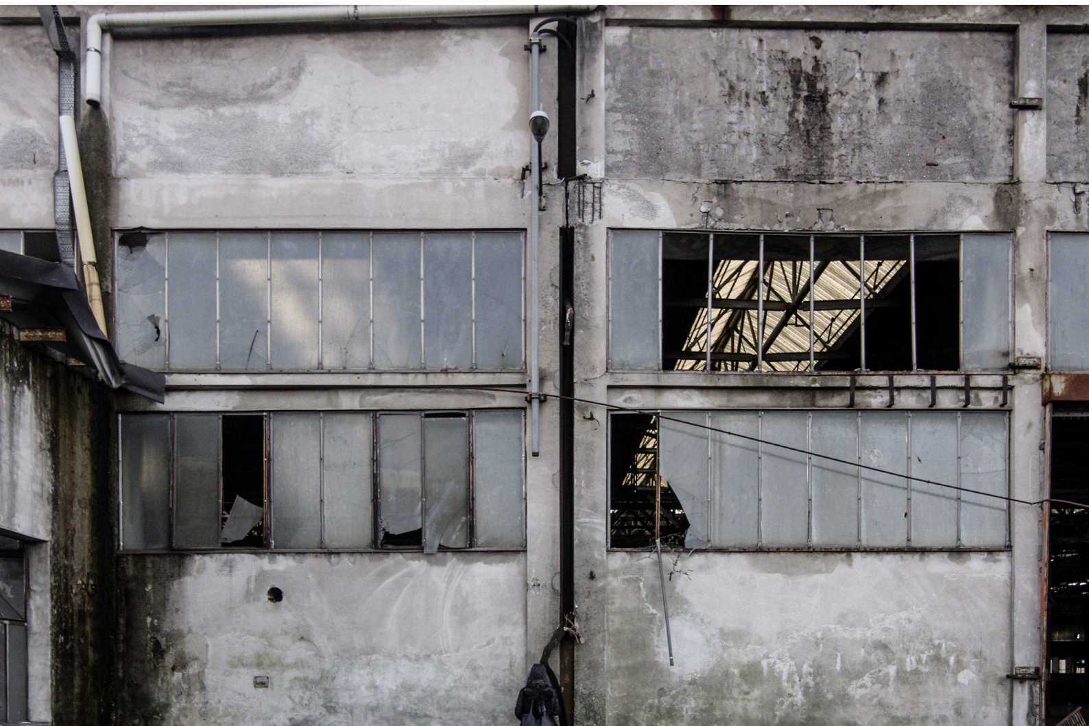
Figura 5.29 - Vista aperture prospetto nord
