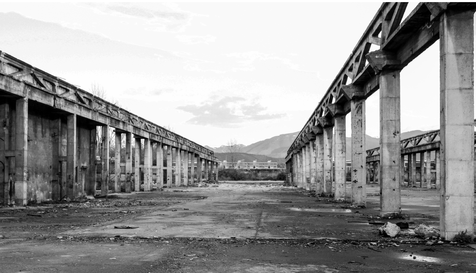
Figura 3.1 - Pietra Curva, strutture esistenti
