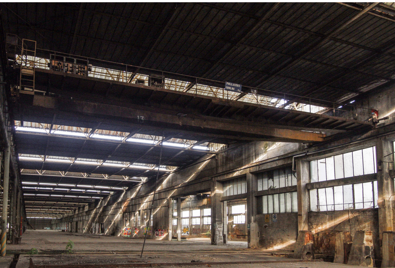
Figura 5.9 - Vista interna prospetto nord
