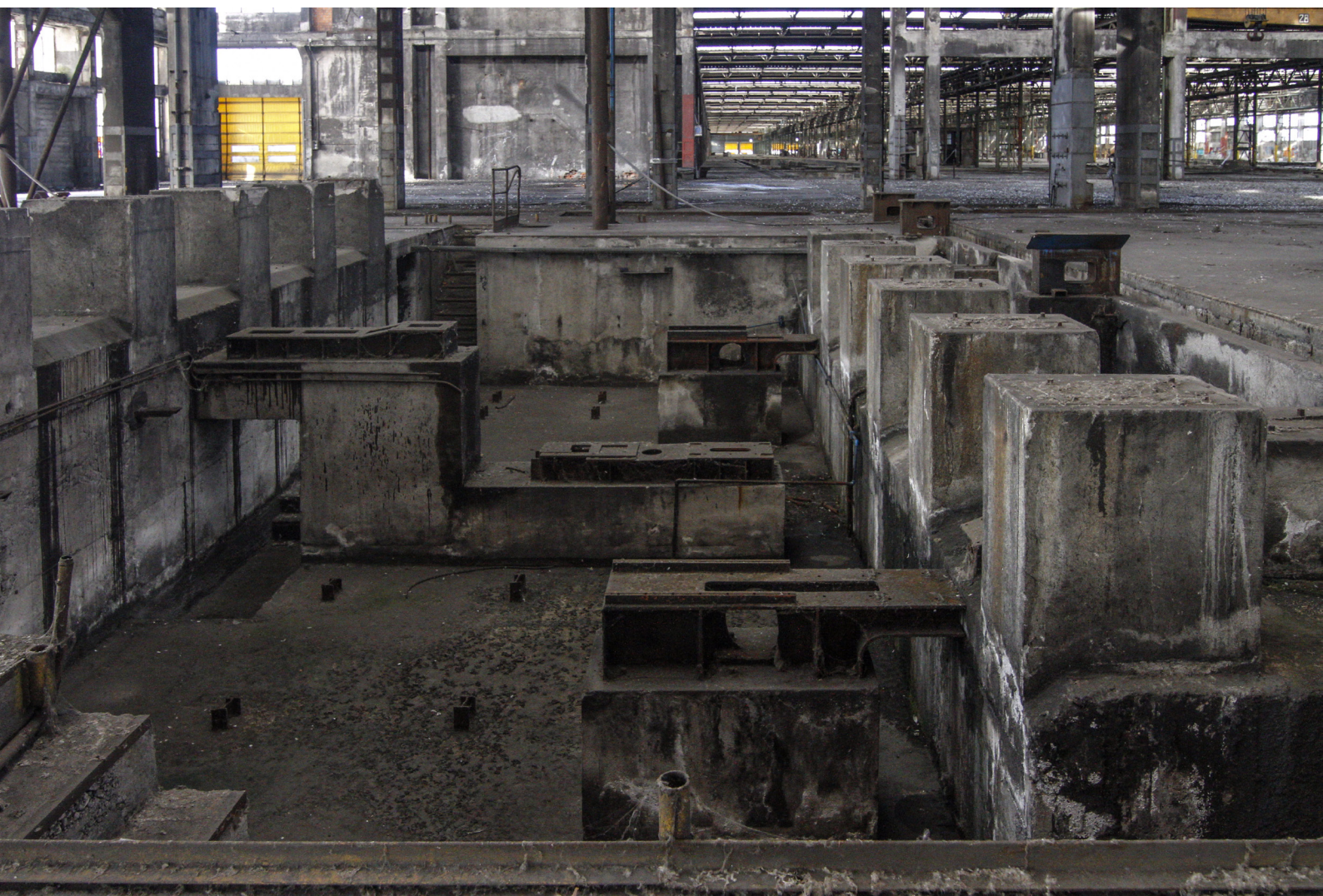
Figura 5.24 - Macchinari interni al tubificio
