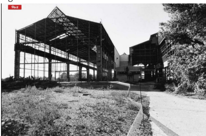
Figura 3.11 - Strutture ex acciaierie Falck
