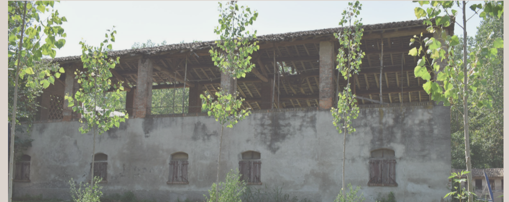
Prospetto est stalla
