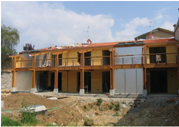
Foto 2.36 Termoriflettenti stratificati - Isolamento delle pareti di una serra di una residenza nella Bergamasca. Lavori eseguiti dalla Ditta Vanoncini SPA, con rotoli Actis.
