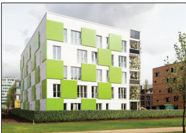
Foto dell'edificio e dettaglio del sistema oscurante.
