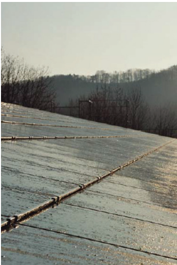
Foto 2.30 Pannelli con integrate capsule di PCM per isolare una copertura dall'esterno.
