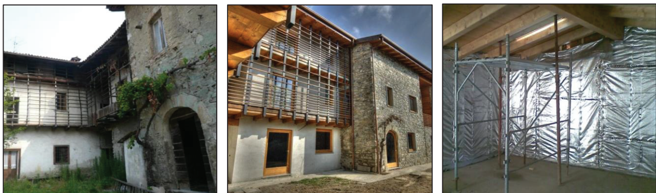
Foto prima e dopo la ristrutturazione e particolare del cappotto con termoriflettenti.
