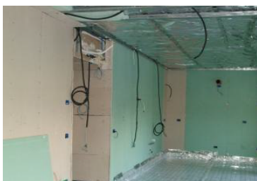
Foto 2.33 Termoriflettenti stratificati - Isolamento di un controsoffitto. Fonte: Ditta PEG.
