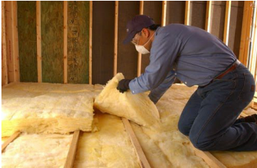
Foto 1.8 Isolante termico tradizionale, di origine minerale - Rotolo in lana di vetro.
