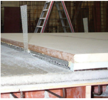
Foto 2.7 VIP - Pannelli prefabbricati per un solaio.
