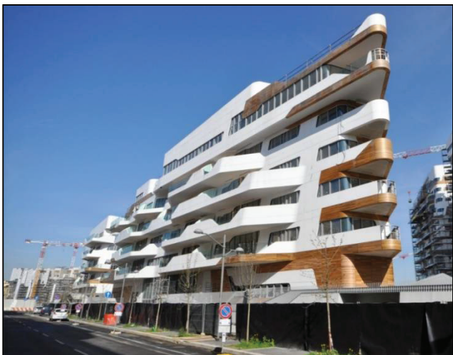
Foto del complesso residenziale e dettaglio del sistema oscurante.
