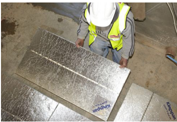
Foto 2.4 VIP - Un operaio applica al pavimento dei pannelli sottovuoto. Ditta Kingspan.
