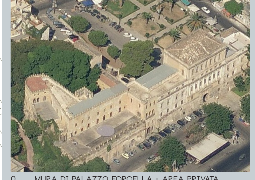
0 MURA DI PALAZZO FORCELLA - AREA PRIVATA, FUORI DAL PERCORSO DI PROGETTO
