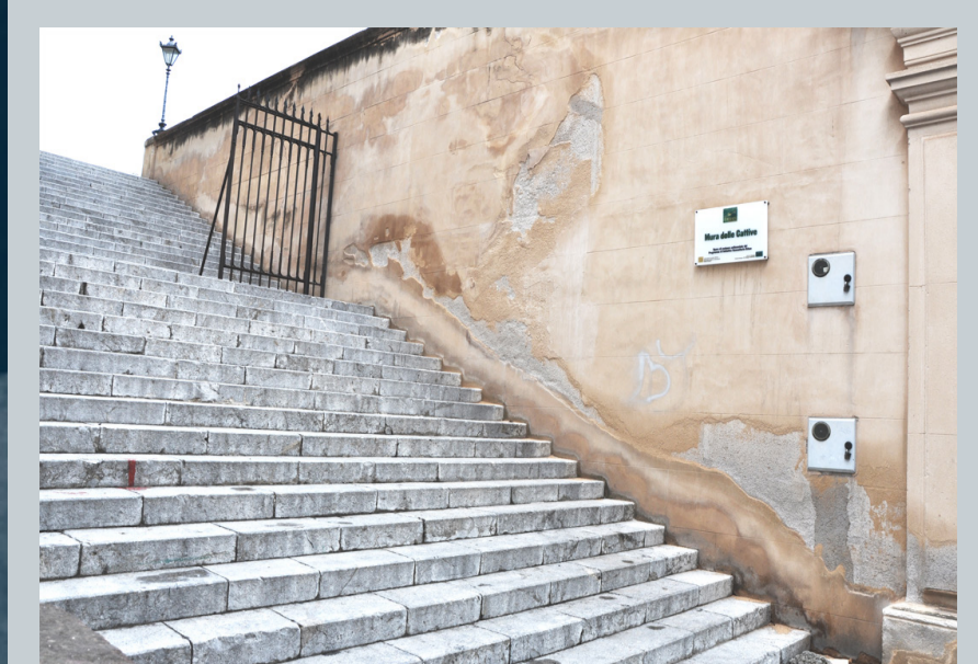
8 SCALE PER MURA DELLE CATTIVE - LATO VIA ALLORO
