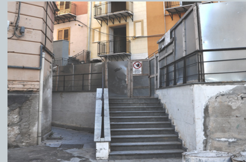
2 SCALE DI ACCESSO MURA LATO SPASIMO
