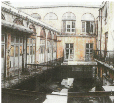
Fig. 108_Vista della corte interna dal livello del primo piano nel 1992
