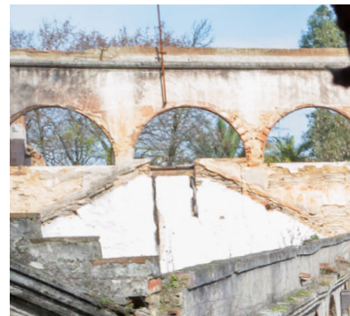
Fig. 131_Ammorsamento del tetto della fabbrica sulla parete della villa operaia
