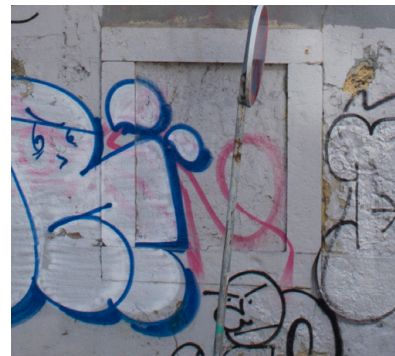
Fig. 133_Tamponamento con mattoni forati intonacati di tutte le aperture del complesso che affacciano so strada
