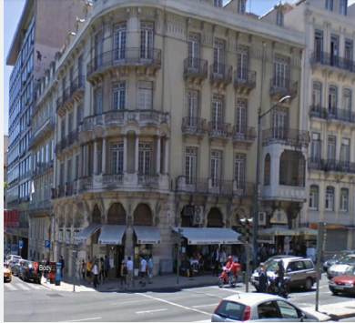
Fig. 81_Avenida da Liberdade 240 in stato di abbandono Fonte: Google street view
