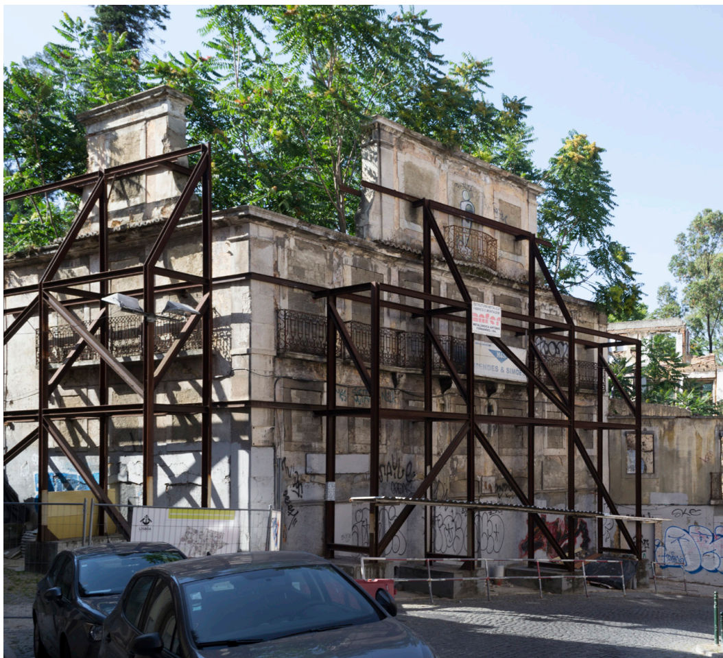
Fig. 114_Prospetto principale ripreso scendendo da Rua da Alegria. In primo piano le strutture metalliche di sostegno
