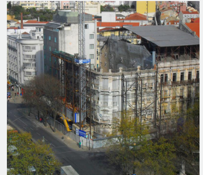
Fig. 84_Avenida da Liberdade 240: im- magini dal cantiere Fonte: http://afaplano.com/progetto?id=243
