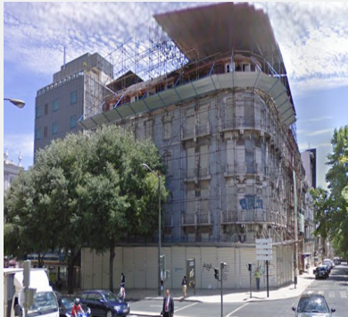
Fig. 83_Avenida da Liberdade 240: im- magini dal cantiere Fonte: http://afaplano.com/progetto?id=243
