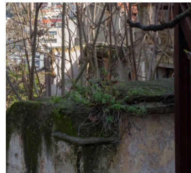
Fig. 135_Patine biologiche e vegetazione infestante sui lacerti murari lasciati esposti agli agenti meteorici interessati da umidità discendente
