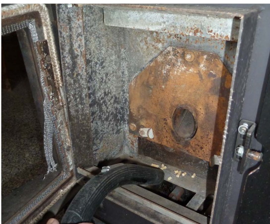
Pulizia camera di combustione
