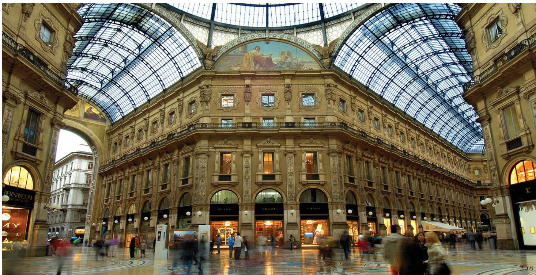
2.10. L'Hotel Town House Galleria all'interno della Galleria Vittorio Emanuele II a Milano.
