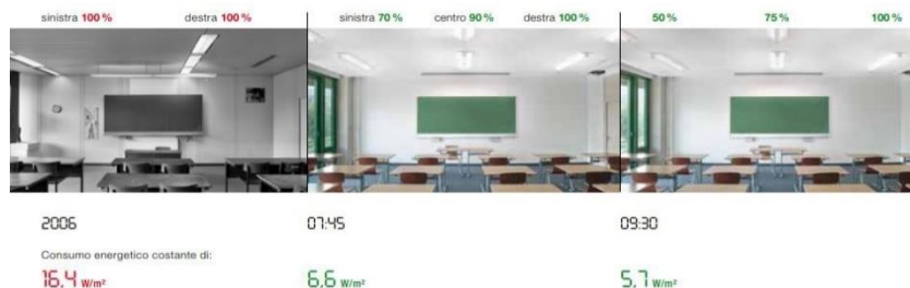
Fig. 5.58 Livello dimming dei gruppi d'illuminazione nel liceo di Sonthofen, prima e dopo la riqualificazione
