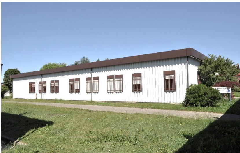
Fig. 3.6 Blocco aule provvisorio costruito nel 1982
