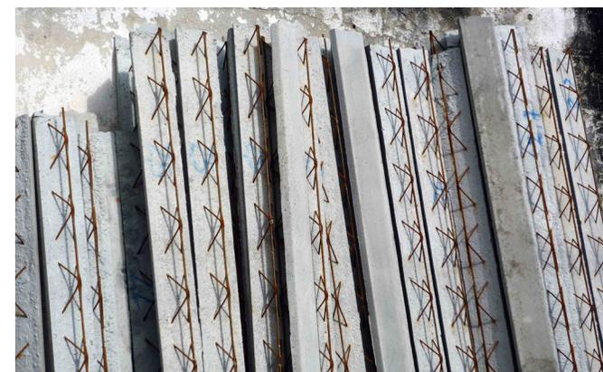
*Figura 2.24 Travetti armati del solaio.*
