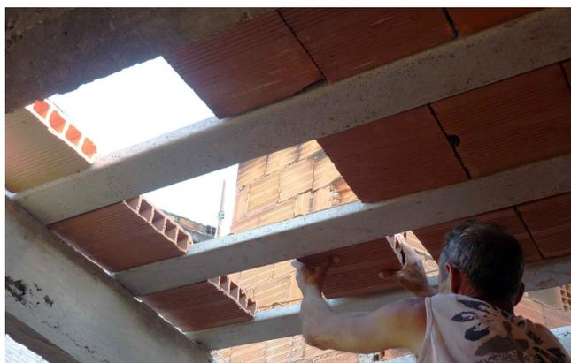
*Figura 2.23 Realizzazione del solaio.*
