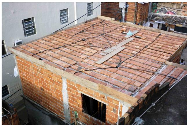
*Figura 2.20 Solaio in cemento e mattoni.*
