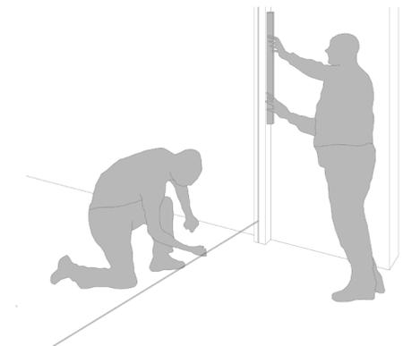
Figura 7.51 Illustrazione delle fasi di tracciamento del piano di posa della futura muratura, fase II
