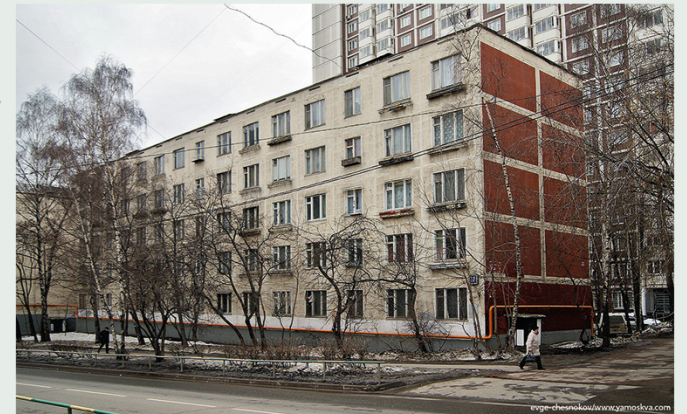
Le prime case sperimentali a pannello sono state costruite nel 1948 a Mosca (serie K-7). Progetto dell'ingegnere V.P. Lagutenko
