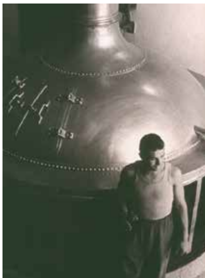
Locale di fabbricazione di Pedavena, anni '20/'30
