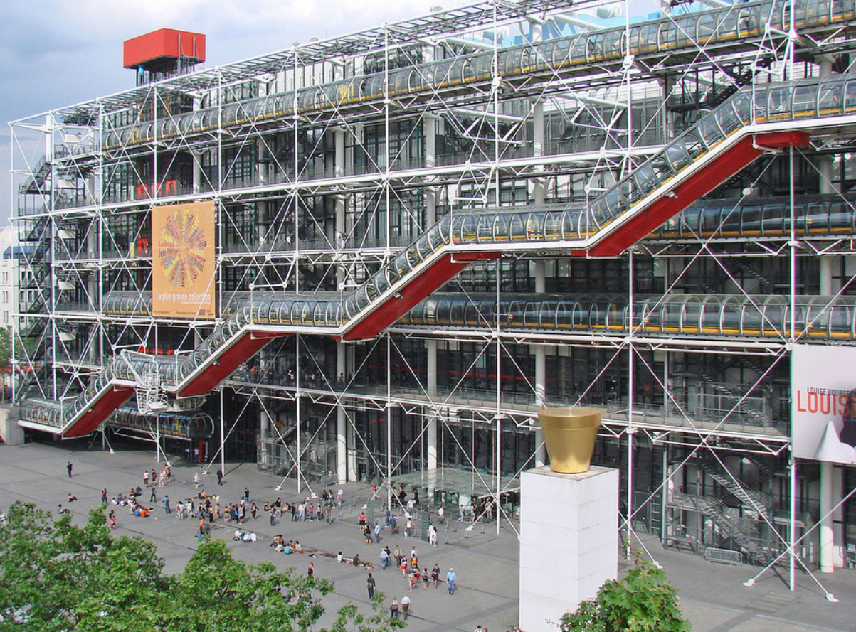
Figura 26 Centre Pompidou, vista del prospetto
