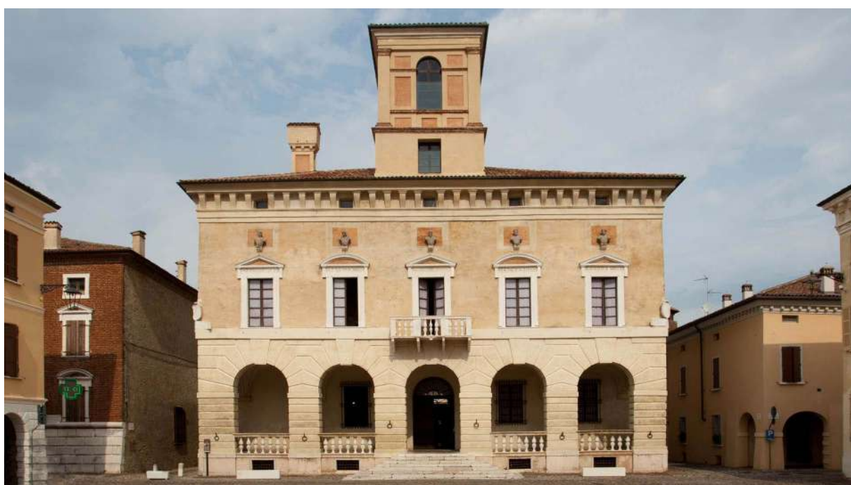
Facciata del Palazzo Ducale.
