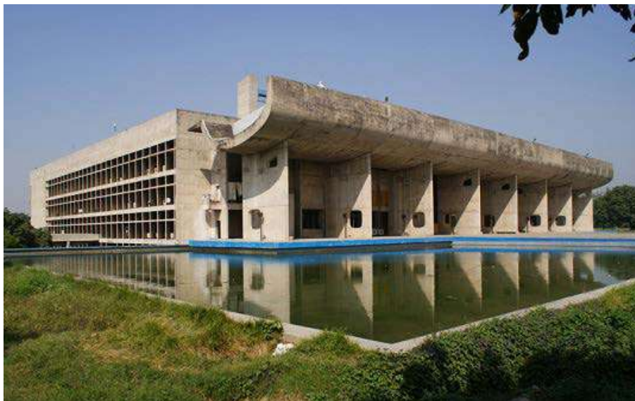
Palazzo dell'Assemblea, Le Corbusier, Chandigarh.
