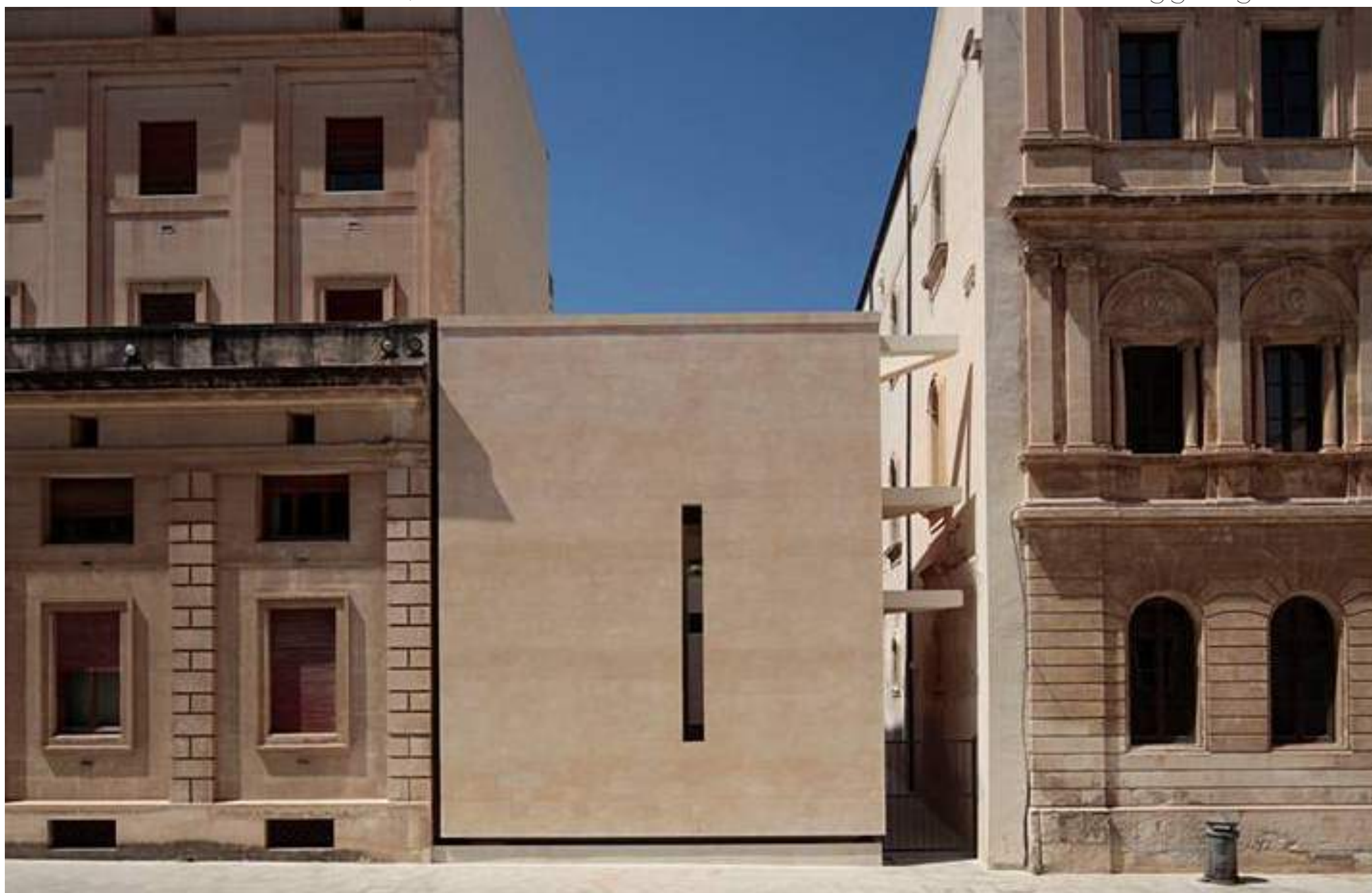
_Intervento di ricucitura con il padiglione Artemision per accedere alla zona degli scavi di Vincenzo Latina a Siracusa in piazza Minerva del 2011
