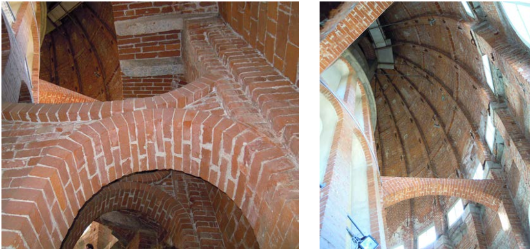
Figura 41 - Sistema di archi "dritti - rovesci"
