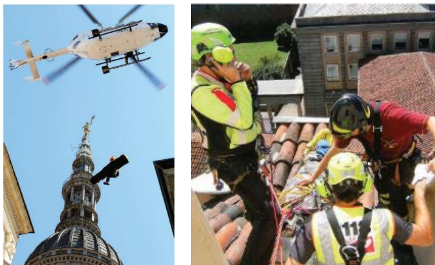
Figura 60 - Intervento con elicottero sulla Cupola di San Gaudenzio
