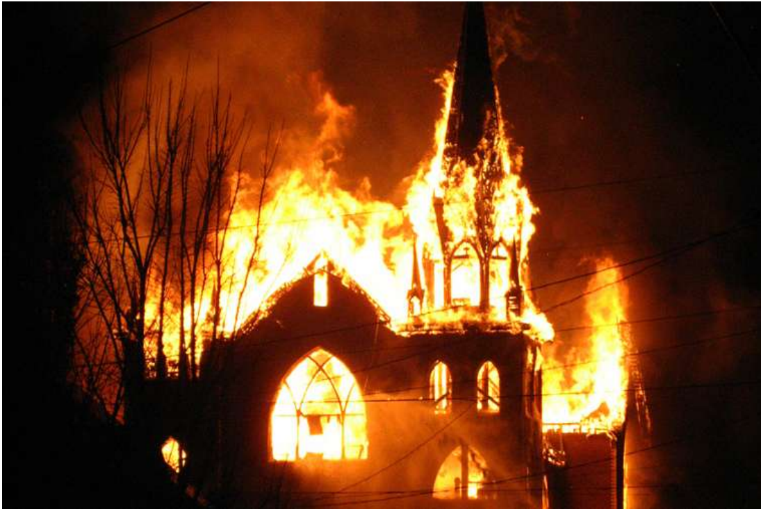
Figura 54 - Incendio in una chiesa a Minneapolis nel 2012
