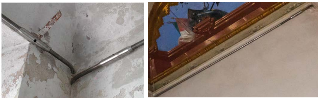
Figura 115 - Dettagli dei tiranti in acciaio inossidabile a Casa Bossi
