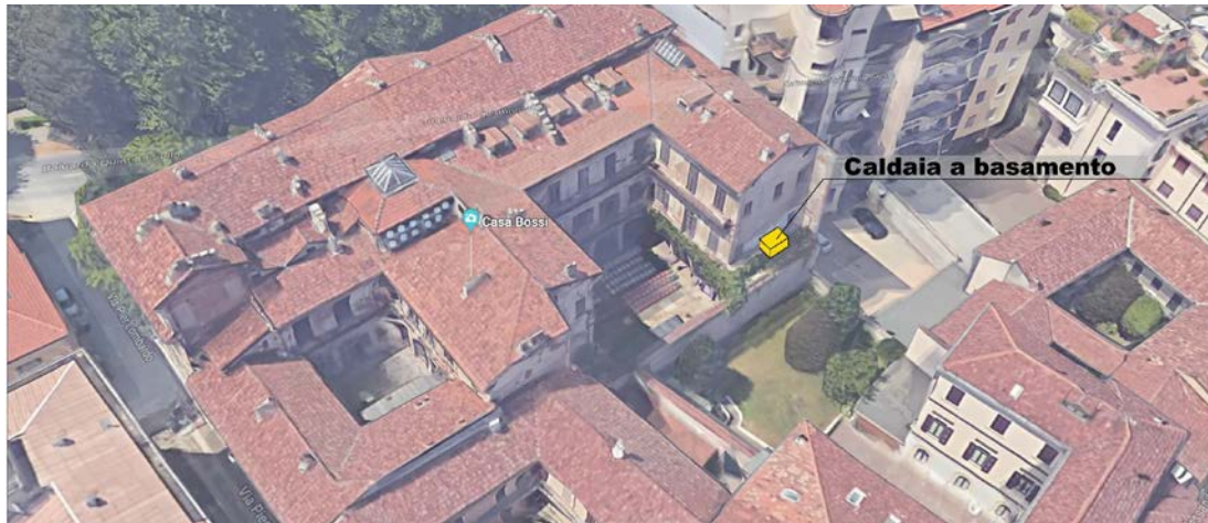
Figura 96 - Posizionamento della centrale termica
