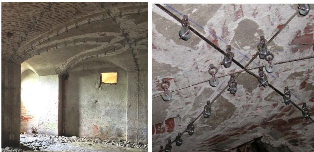
Figura 104 - Arco armato nelle volte del piano interrato
