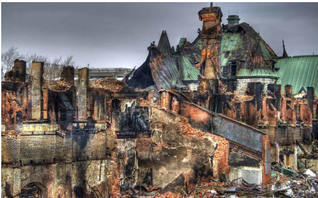
Figura 49 - Conseguenze dell'incendio della Quebec City Armoury, 2008
